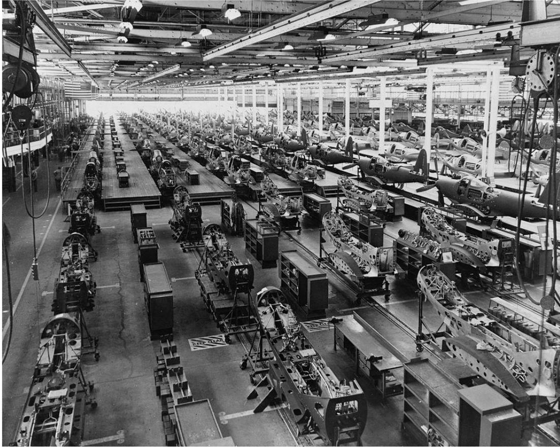
Figura 10 - Produzione in serie dell'aereo bellico Aircobra (seconda guerra mondiale)
