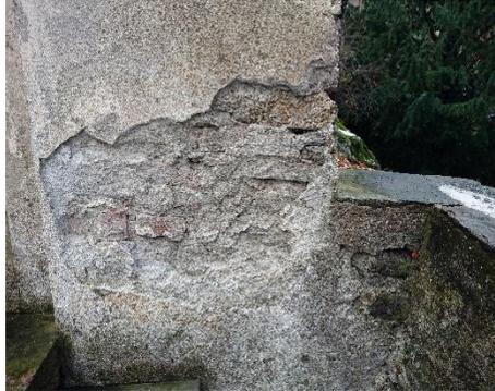
Figura 31 - Dettaglio di muratura esterna deteriorata tra la cappella 3 e l'attacco del muro di contenimento del terrazzamento. Foto: A. Ursini.
