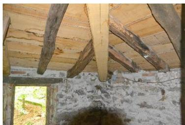
Figura 37 - Dettaglio della nuova trave portante ad angolo, con travi secondarie originali (c.4). Foto: A. Ursini
