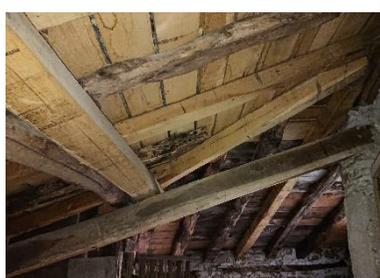
Figura 36 - Vista d'insieme dell'orditura in travi lignee in copertura (c.4). Foto: A. Ursini
