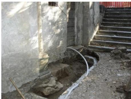
Figura 38 - Dettaglio dello scavo e posa degli impianti. Fonte: <http://www.parks.it/riserva.sacro.monte.varallo>
