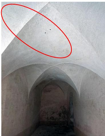
Figura 30 - Vista del corridoio di passaggio tra c. 2 e c. 3 con alterazione della pigmentazione superficiale degli intonaci: presenza di umidità di risalita ed infiltrazioni dal quadro fessurativo nella superficie voltata superiore.
