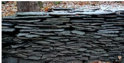
Figura 32 - Deposito di beole utilizzate per eventuali sostituzioni nelle coperture del Sacro Monte. Foto: A. Ursini.
