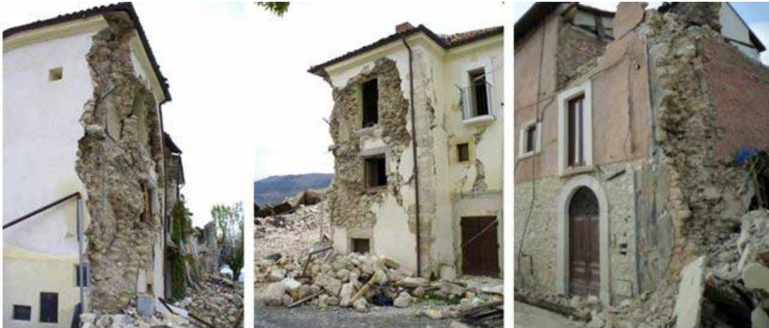
**Figura 2. 2– Crolli dovuti alla fatiscenza intrinseca della muratura**
