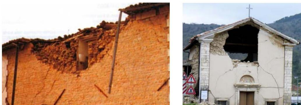
**Figura 2. 11– Esempio di flessione orizzontale.**
