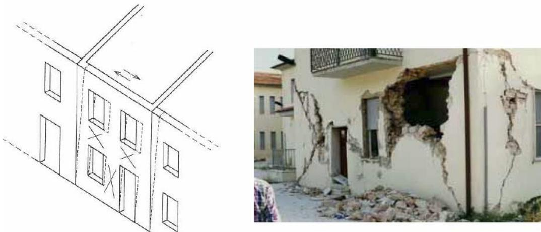
Figura 2. 18– Meccanismi nel piano – rottura a taglio dei maschi murari.
