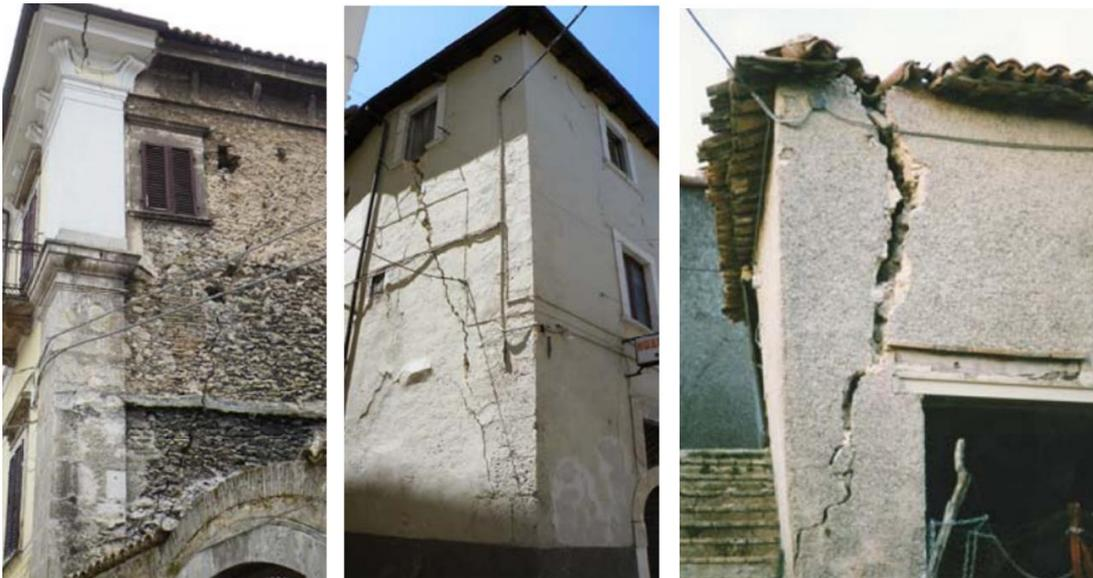
**Figura 2. 13– Esempio di ribaltamento composto.**
