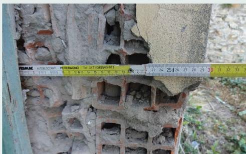
**3 Particolare della stratigrafia e delle caratteristiche dimensionali della muratura portante del corpo di servizio**
