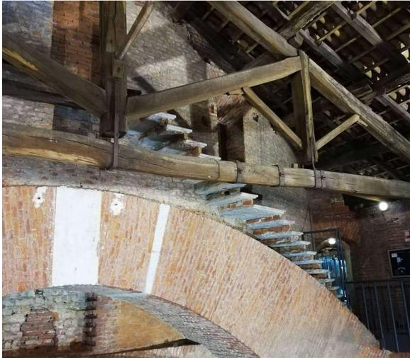
Figura 4 Cupola di San Gaudenzio – Dettaglio degli arconi di rinforzo (Fonte: foto dell'autrice)
