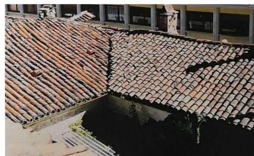
Figura 20 Casa Bossi - Particolare del manto di copertura originale (Fonte: Progetto di rifacimento del manto di copertura di Casa Bossi, Comune di Novara)
