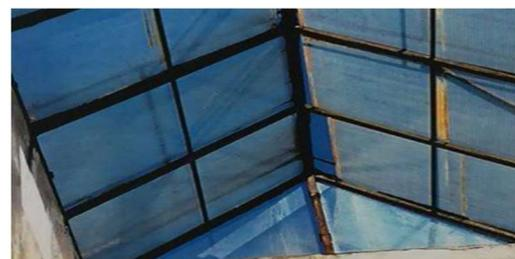
Figura 21 Casa Bossi - Particolare dei lucernai originali (Fonte: Progetto di rifacimento del manto di copertura di Casa Bossi, Comune di Novara)
