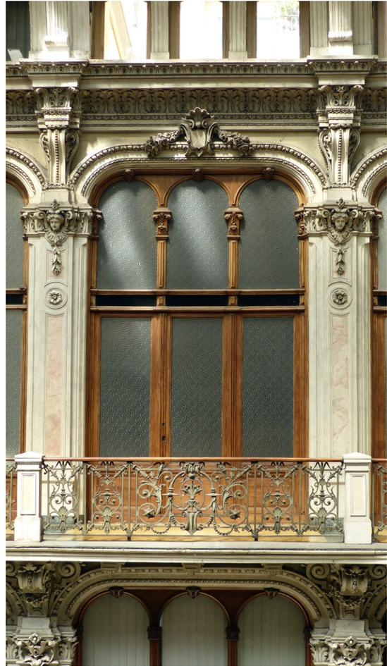
**Fig. 41-42** Torino, galleria Dell'Industria Subalpina, tamponamenti lignei delle arcate al piano inferiore e al piano superiore, particolari.
