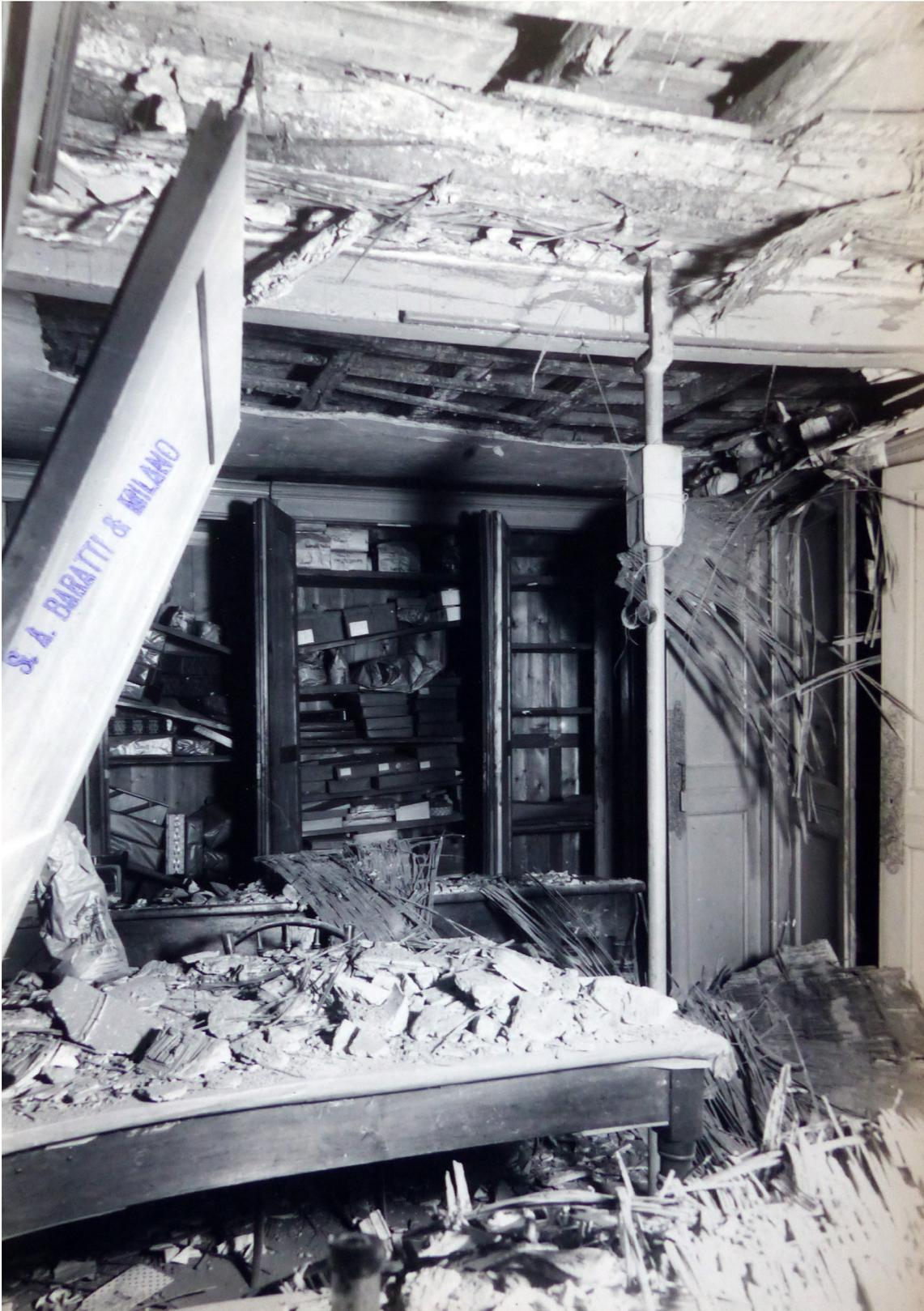
**Fig. 110** Confetteria Baratti e Milano, particolare della distruzione dei soffitti con successivo puntellamento della struttura con sostegni metallici (ASTo, *Intendenza di Finanza*, Reparto IV, *Danni di Guerra*, maggio 3268).
