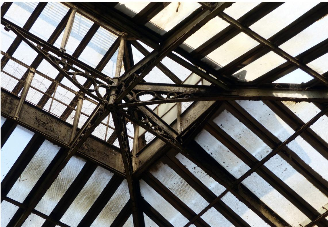
**Fig. 46-47** Torino, galleria Dell'Industria Subalpina, copertura vetrata, innesto e particolare della modifica apportata alla composizione originaria.
