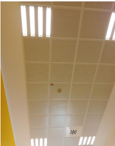
Figura 45. Pannelli radianti modulari a soffitto nell'aula 18 al piano secondo.
