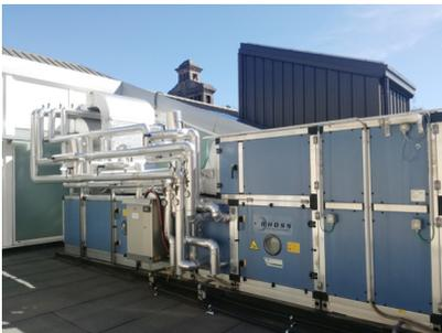
**Figura 49.** UTA per la ventilazione meccanica delle aule posta al secondo piano, tra l'aula 13 e il vano ascensore.
