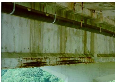
(a) *Degrado della trave, rilevata tramite l'utilizzo di piattaforme mobili*
