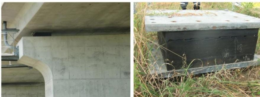
Figura 2.8: Esempio di appoggio pot a disco
