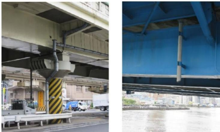
Figura 2.9: Esempi di sistemi di drenaggio
