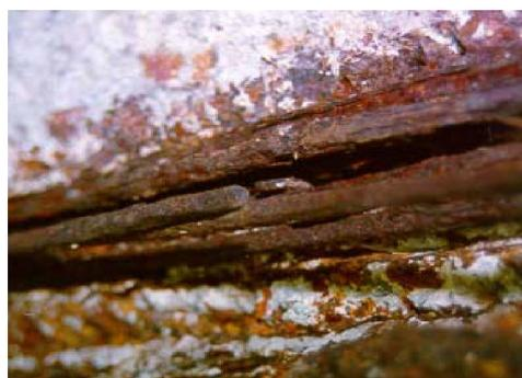
(b) *Degrado delle armature di precompressione*
