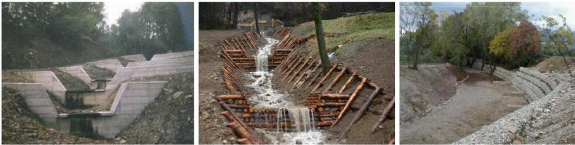
Figura 18: opere di consolidamento sul fondo del canale (opere trasversali a sinistra) e sulle sponde (opere longitudinali a destra)
