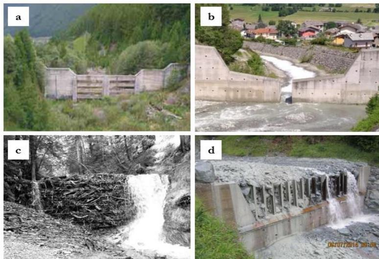
Figura 21: esempi di briglie filtranti aperte a finestra (a), a fessura (b), a reticolo (c), a pettine (d)
