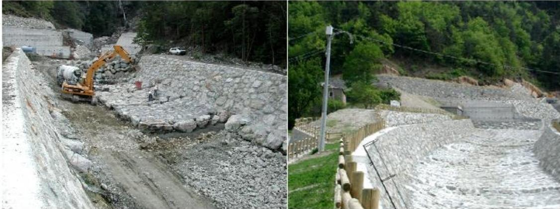
Figura 24: canale di smaltimento in fase di costruzione a sinistra, a destra in fase di esercizio (Pirulli, 2014)
