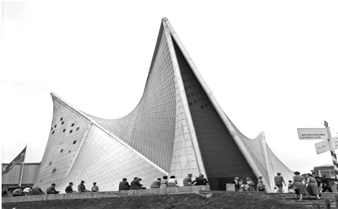
[Fig. 67] Il padiglione Philips, progettato da Le Corbusier in occasione dell'Esposizione Universale del 1958 a Bruxelles. Il progetto presenta già un'idea primordiale di approccio parametrico in merito alla forma, la quale doveva soddisfare determinati requisiti acustici e di illuminazione. Purtroppo il padiglione venne smantellato poco tempo dopo. Photo credit ©Wikimedia commons.
