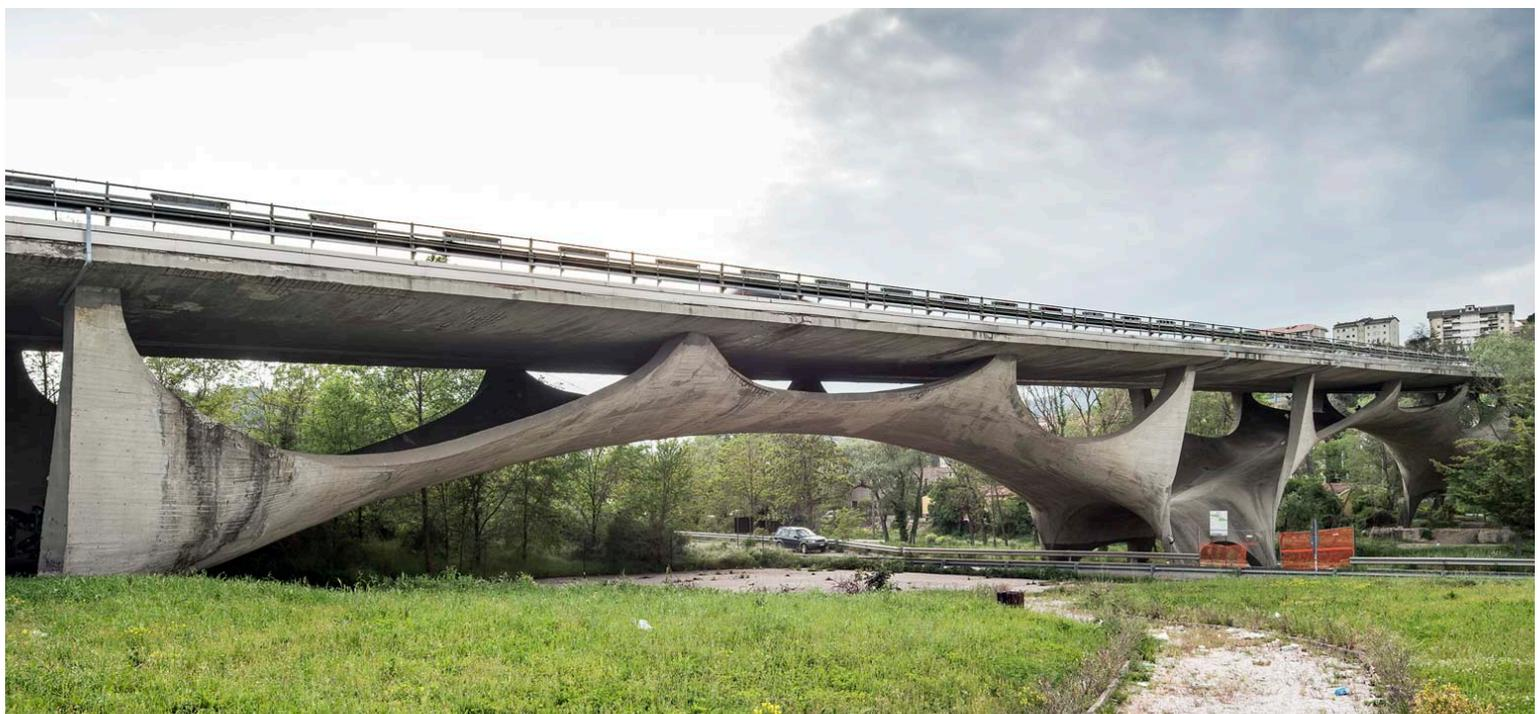
procedimento progettuale di base, indipendentemente dal fatto che l'ispirazione potesse partire da una pianta di girasole, era volto soprattutto alla ricerca di una forma efficiente soprattutto strutturalmente.
