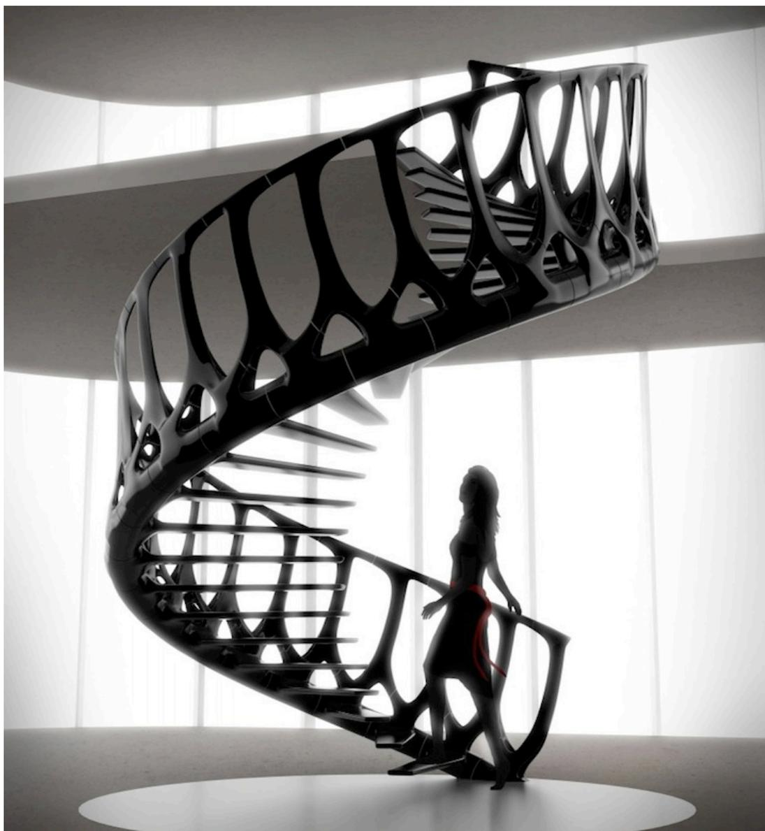
scalino inoltre sono attraversati all'interno da una spirale strutturale continua, rinforzati da una spuma resistente e una rete di barre di acciaio. Tali elementi insieme alle due grandi piastre di acciaio poste alle estremità permettono alla scala di resistere con successo alle forze rotazionali e torsionali derivanti dalla forma a spirale e dagli scalini a sbalzo.
