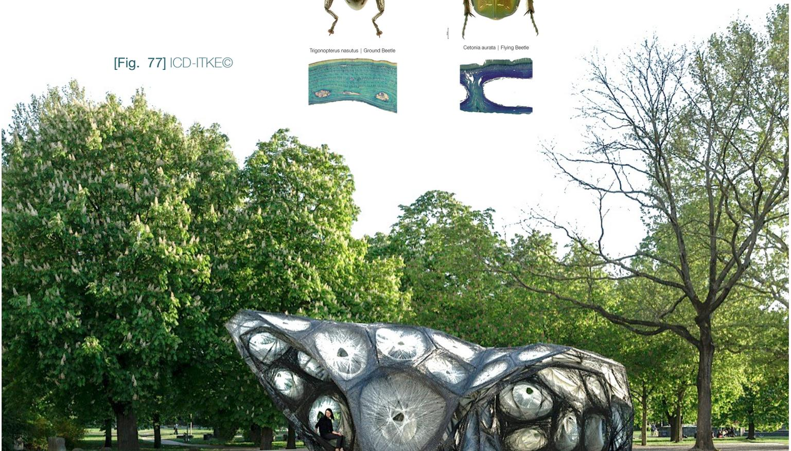
In seguito, tramite programmi di modellazione parametrica è stato possibile riprodurre le forme geometriche del guscio, creando un sistema a doppio strato.
