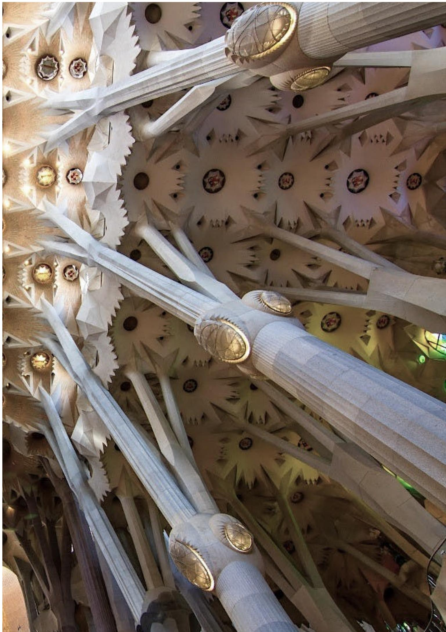
Per risolvere i grandi problemi ingegneristici della basilica e non ricorrere ad un'architettura così massiccia come quella gotica, il segreto fu introdurre, per la prima volta nell'architettura, il concetto della catenaria<sup>63</sup>, la curva gaudiana per eccellenza, presente anche nei progetti di Casa Batlló, Parc Güell, del Colegio de las Teresinas e tanti altri. Queste le parole di Gaudí:
