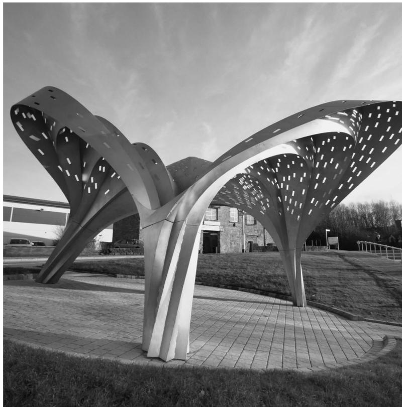
[Fig. 82] Rainbow Gate, studio Tonkin Liu, 2012, Burnley, Inghilterra. Il nome del padiglione deriva dall'effetto della rifrazione della luce che passa attraverso la copertura in lamiera perforata. Photo credit Tonkin Liu©.
