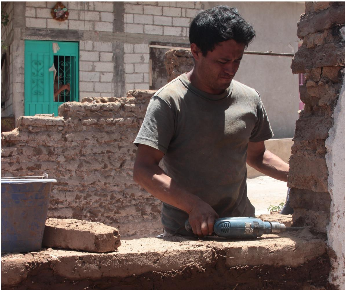
**28 ▲** Perforazione della malta esistente per l'inserimento del tondino.
