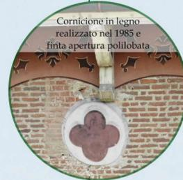
Cornicione in legno realizzato nel 1985 e finta apertura polilobata
