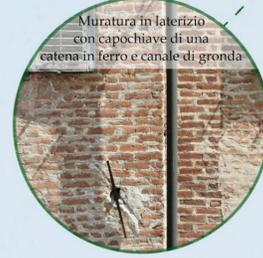
Muratura in laterizio con capochiave di una catena in ferro e canale di gronda
