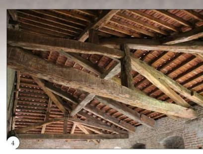
4 Struttura lignea di copertura del corpo centrale
