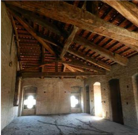
*Sottotetto con struttura lignea a vista*
