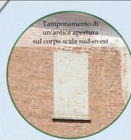
Tamponamento di un'antica apertura sul corpo scala sud-ovest
