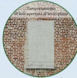
Tamponamento di una apertura al terzo piano
