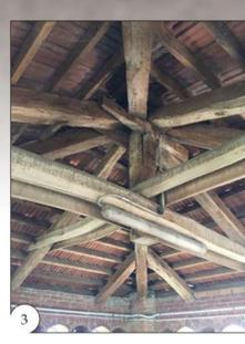
3 Struttura lignea di copertura della torretta
