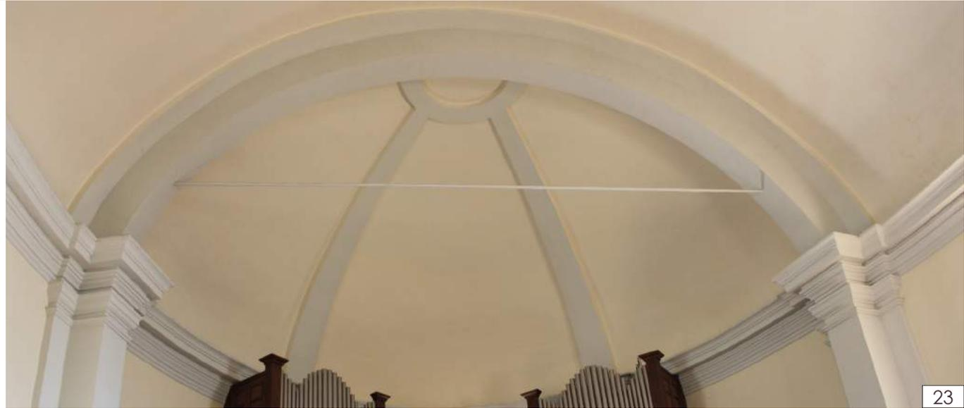
Dai documenti archivistici è emerso che la copertura fu ultimata prima della costruzione della volta, poichè in un primo tempo era prevista la realizzazione di un semplice solaio piano, forse di una volta in camera-canna (in altri templi valdesi delle valli i soffitti voltati sono realizzati con questa tecnica). È possibile ipotizzare vista la loro posizione che, nella sequenza costruttiva, i primi elementi della volta ad essere realizzati siano stati proprio gli arconi.
