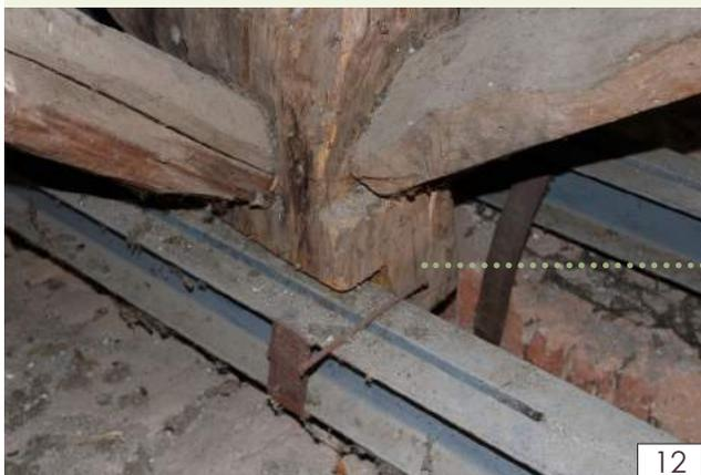
le capriate lignee originarie sono inglobate in due strutture metalliche, sollevate e poste in opera singolarmente e in seguito saldate ed unite tra loro;
