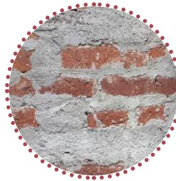
i giunti di malta sono piuttosto spessi e irregolari, con dimensione variabile tra i 2 e i 3 cm
