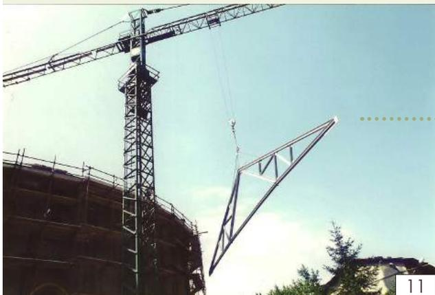
a copertura smontata, la struttura, già saldata, è stata sollevata grazie ad una gru e collocata in opera
