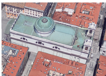
2. Veduta aerea della chiesa di Sant'Antonio
