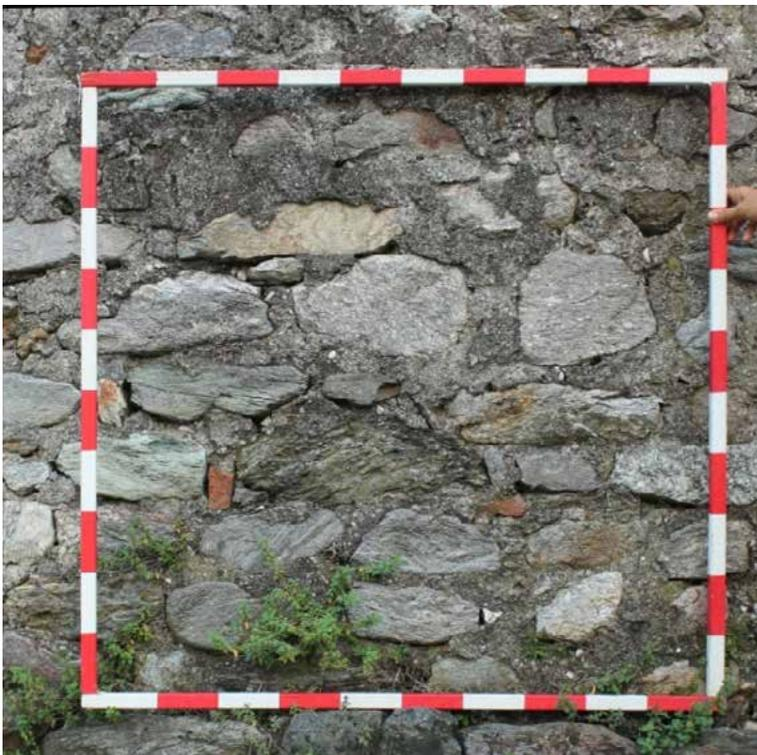
La muratura è composta da blocchi di pietra sbalzati irregolarmente; in questo caso non è possibile percepire nettamente le linee di contorno delle bozze, arrivando quindi a conclusioni sullo stato di lavorazione. Questa situazione è dovuta alla presenza dell'intonaco che in parte ricopre ancora alcuni tratti di muro, occultando alcune pietre e celandone parte di altre.
