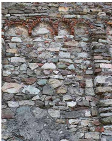
**Fig. 60.** Gli archetti pensili della seconda campata partendo da est. (Foto IB)
