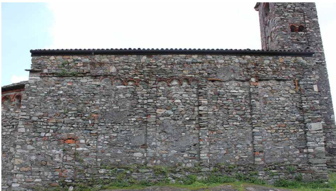
**Fig. 57.** Muratura perimetrale nord della cappella: ad occhio nudo è impossibile localizzare la discontinuità muraria sulla quale si è concentrata la critica nella definizione dei rapporti di stratificazione storica. Tale frattura dovrebbe essere posizionata circa ad un terzo dell'ampiezza della terza campata a partire da nord-est. (Foto IB)
