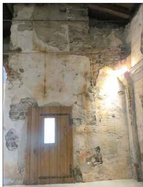
**Fig. 84.** L'interno: si vede chiaramente la fessura tra il clocher porche e il segmento di facciata sul lato nord, a destra del campanile.
