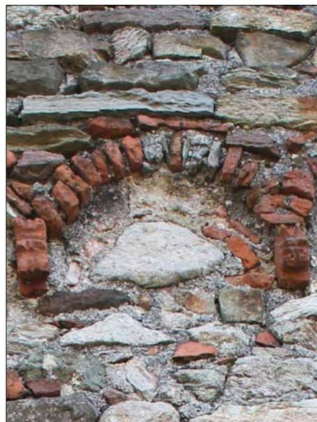
**Fig. 128.** Peducci sagomanti ad onde con un taglio centrale presenti sul prospetto nord di S. Stefano a Chiaverano. Si riconosce la sagoma anche se presentano forte erosione.
