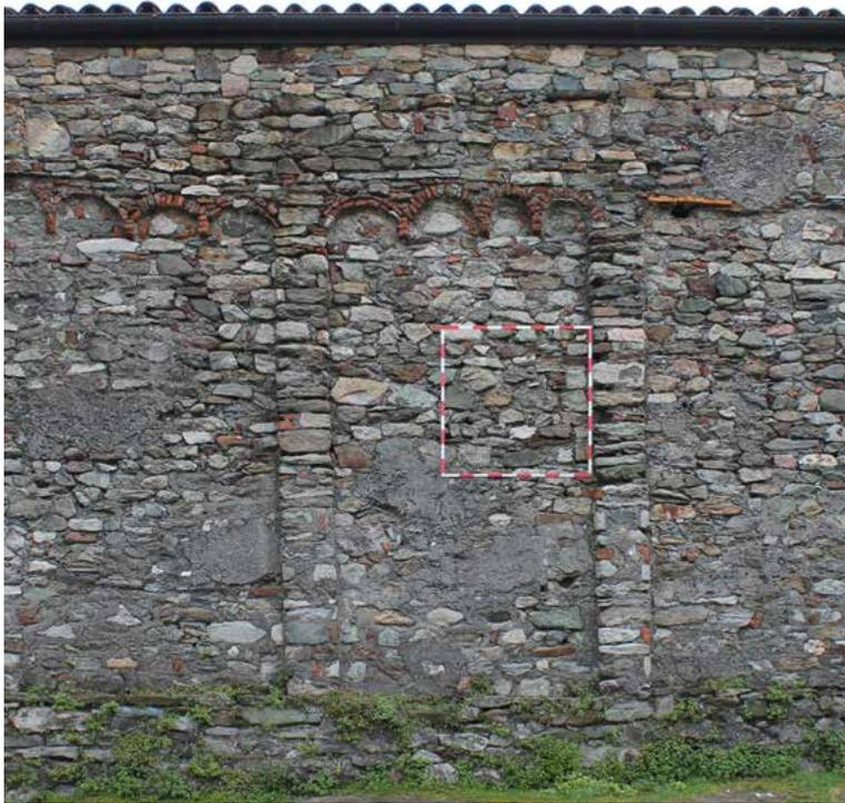
Il campione di muratura è stato selezionato con cura di non comprendere, al suo interno, lo strato d'intonaco che copre la parte inferiore di questa campata. Così facendo è stato possibile analizzare questa porzione di muratura, e poter prendere in considerazione le percentuali della sua composizione. Le due campate in esame sono quelle che ancora presentano la decorazione ad archetti.
