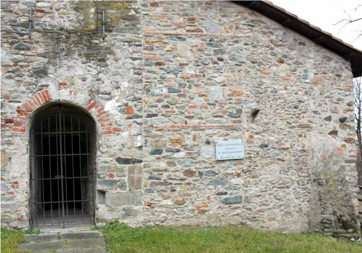
**Fig. 39.** In facciata, a fianco del clocher-porche, si distinguono con chiarezza le diverse tessiture murarie che si traducono in diverse Unità Edilizie. Foto: IB
