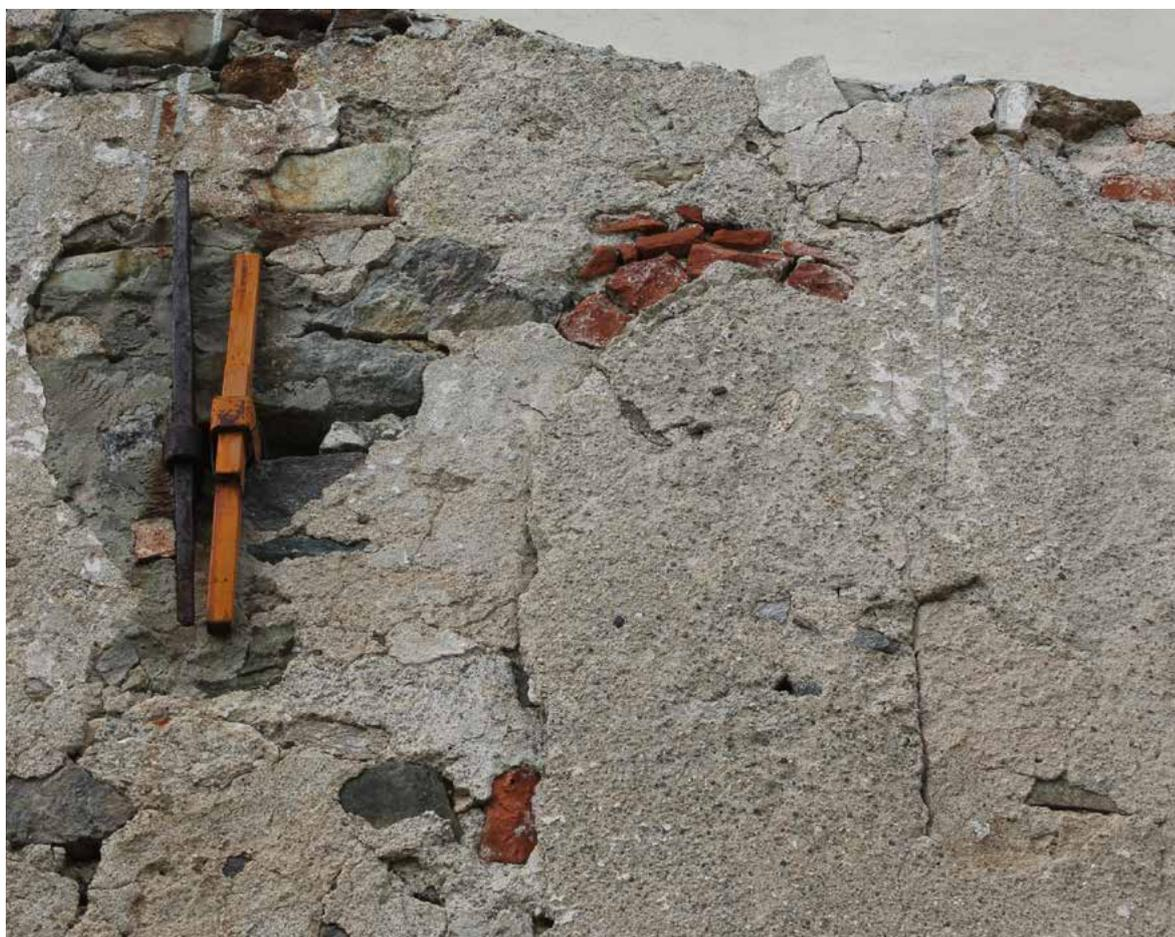
**Figura 65.** Ciò che resta di una teoria di archetti pensili nascosta sotto l'intonaco, oppure, potrebbe trattarsi della ghiera in mattoni di una monofora.
