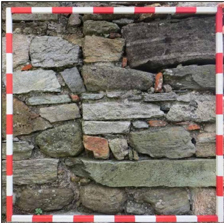
La muratura è composta da blocchi di pietra squadrati in modo grossolano, con elementi dalle dimensioni prevalentemente allungate ed altri di dimensioni minori. E' evidente l'uso sia di frammenti di laterizi, sia di alcune scaglie di pietra per colmare alcuni vuoti. Le pietre sono disposte in modo ordinato, rispettando abbastanza accuratamente l'orizzontalità dei corsi.
