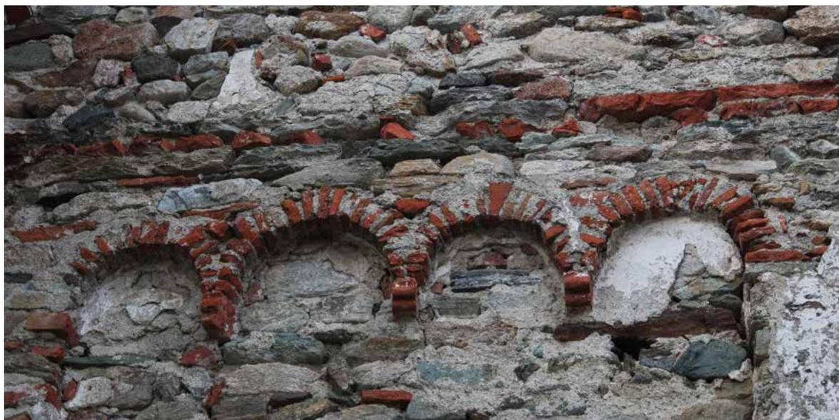
**Fig. 62.** Gli archetti pensili sulla prima campata, partendo da est, del prospetto sud. (Foto: IB)
