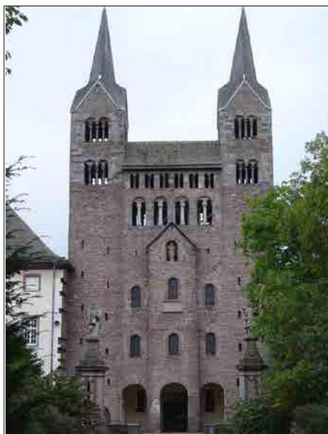
**Fig. 11.** Abbazia di Corvey. La facciata è costituita da un unico blocco occidentale inquadrato da due torri contenenti le scale.
