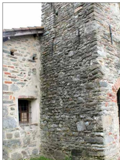
**Fig. 79.** Il lato nord del campanile che sporge in avanti di 2,85 m. Si può notare nell’angolo in alto tra il campanile e la facciata come il campanile sporga totalmente in avanti e non sia inglobato nel muro retrostante.
