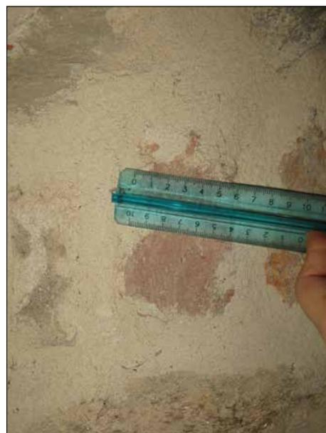
**Fig. 131.** I mattoni disposti a spina di pesce dell' UE19 sono chiaramente di fattura moderna date le dimensioni rilevate.
