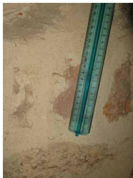
**Fig. 42.** I mattoni disposti a spina di pesce dell' UE19 con dimensioni di 6x12x25 cm.
