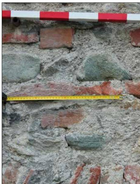
**Fig. 125.** Mattone *sesquipedale* misurato sul prospetto sud della chiesa di Bollengo.
