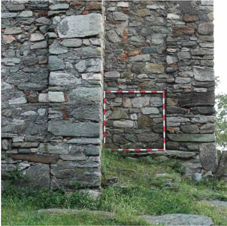
Il campione C\_SSC8 è stato scelto per analizzare la muratura del clocher-porche senza intercorrere tra UF differenti oppure, come nel caso del campione C\_SSC1, elementi strutturali come il cantonale. Pertanto, è stata scelta la porzione di muratura compresa tra il muro in facciata, che si appoggia al campanile, e il cantonale.
