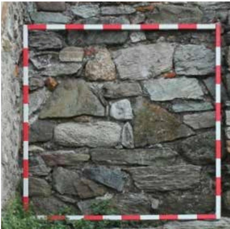
La muratura è composta da blocchi di pietra squadrati in maniera veloce per essere messi in opera. L'orizzontalità dei corsi è interrotta dalla presenza di alcune bozze derivanti probabilmente da scarti di lavorazione, che assumono forme particolari riconducibili al triangolo. L'uso di zeppe è frequente e serve per regolarizzare l'andamento della muratura. Sono presenti scarti di lavorazione in laterizio. E' possibile analizzare la percentuale di composizione del campione.
