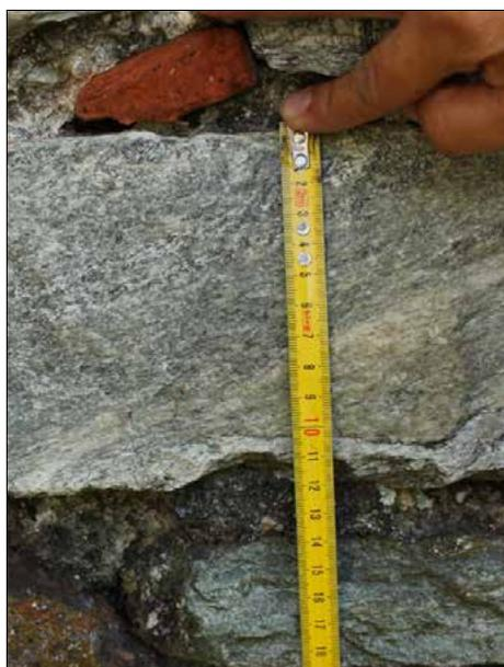
**Fig. 126.** Misurazioni effettuate sulla muratura del prospetto nord della chiesa di S. Stefano a Chiaverano. Le bozze tendono ad avere un' altezza costante tra gli 11 e i 15 cm.
