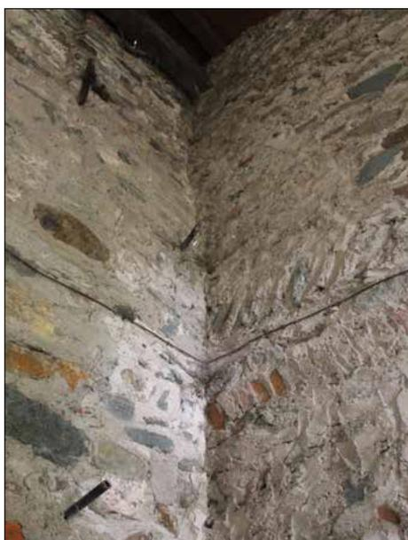
**Fig. 80.1.** Le due murature sono difficilmente distinguibili a causa dell'intonaco, tuttavia sicuramente non sono amorsate data la disposizione degli elementi.
