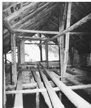
Fig. 70: solaio in legno in Val Troncea.
