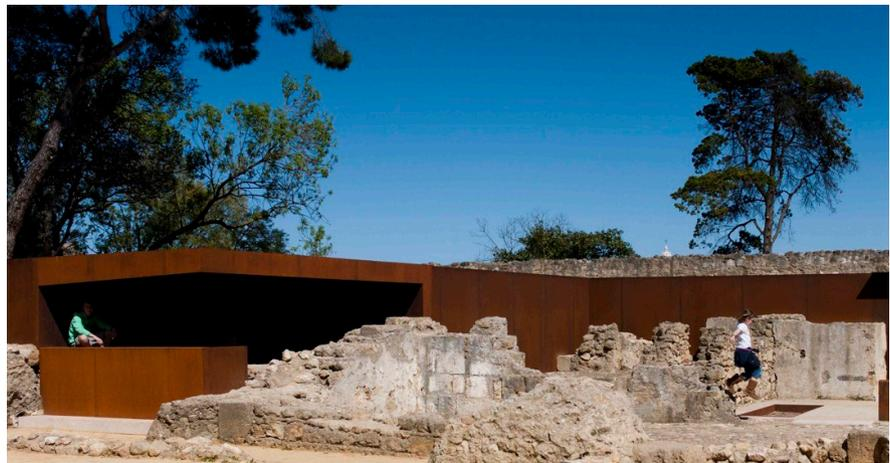
Il progetto di J. L. Carriho da Graca (2010) consiste in volume realizzato con un sistema di tubolari metallici rivestiti con pannelli bianchi in cartongesso e la copertura è composta da un doppio strato di policarbonato per controllare l'irraggiamento solare. Fra le tracce archeologiche e i nuovi muri sospesi, passa solo una "lama di luce" che illumina i reperti e allo stesso tempo conferisce al volume un carattere sospeso e astratto (Fig. 48).
