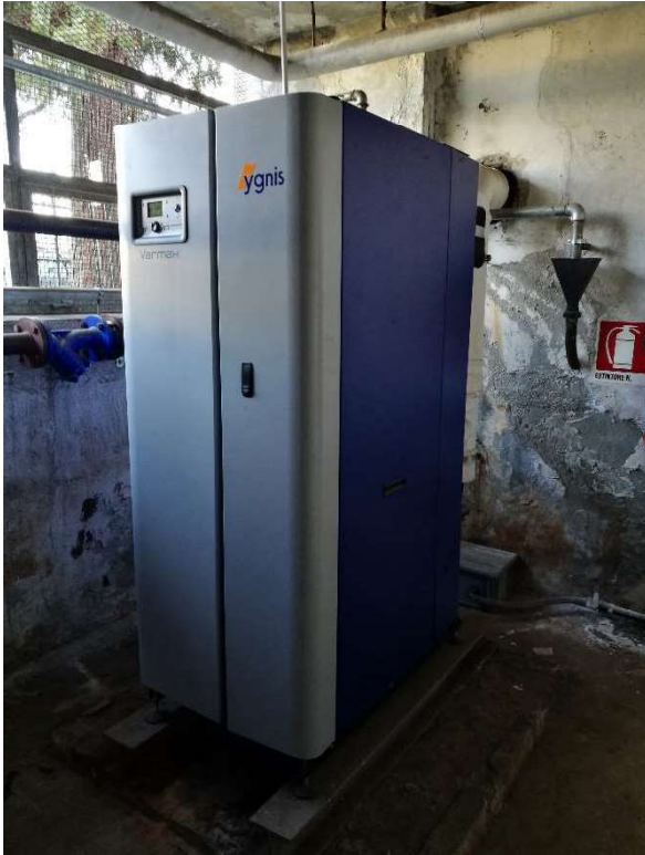
Figura 9.7: caldaia a condensazione YGNIS VARMAX.
