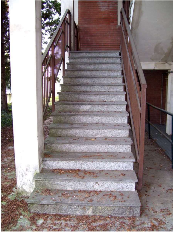
Figura 7.11: scala di sicurezza esterna originaria in c.a. armato.
