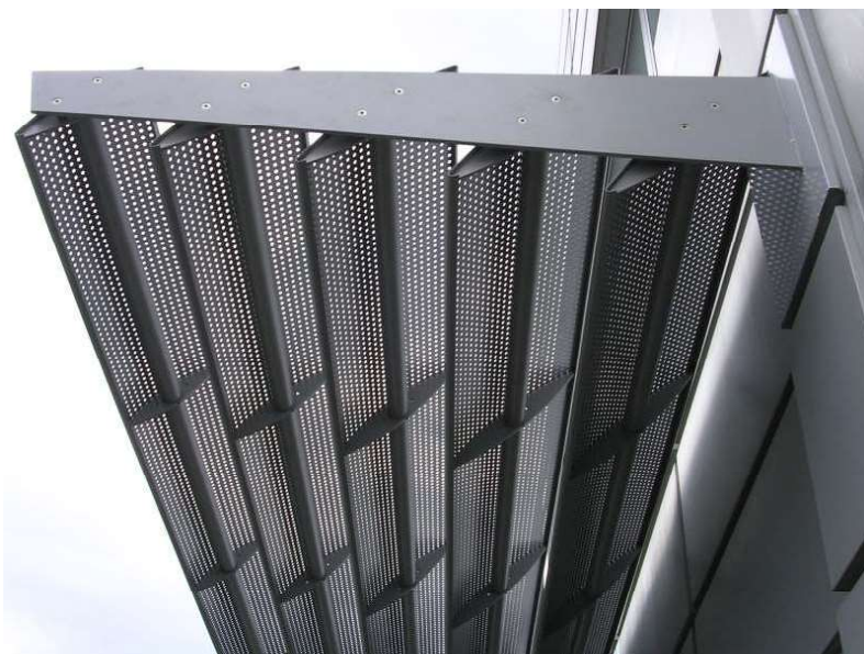
Figura 10.22: dettaglio frangisole in lamiera di alluminio forato, NACO Frangisole AIRLUX, posato su mensola orizzontale.
