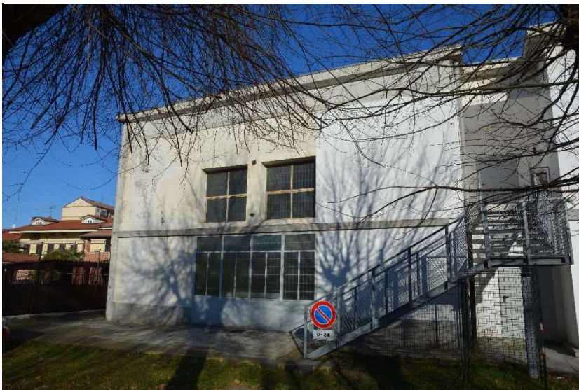
Figura 7.19: prospetto sud, palestra.
