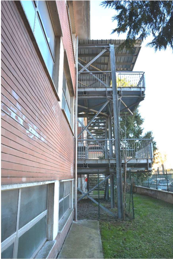
Figura 7.26: scala di sicurezza esterna a nord (2008).
