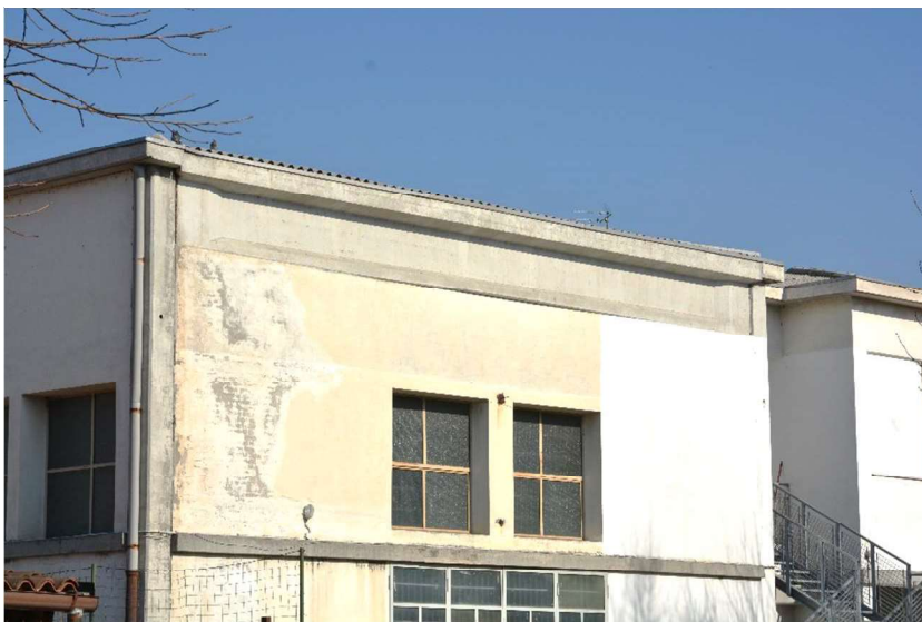
Figura 7.22: prospetto sud, palestra.
