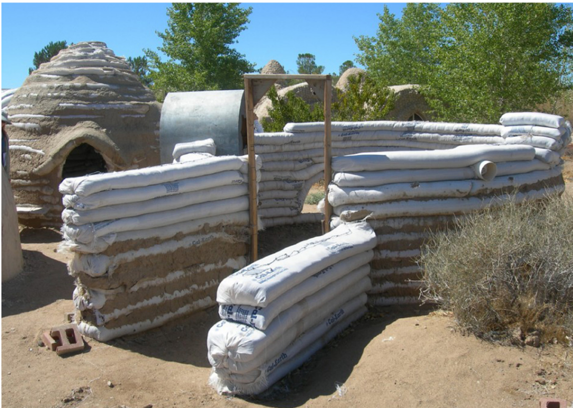
Immagine 5: Nader Kahlili, dimostrazione di costruzione con sacchi terra per situazioni di emergenza abitativa. Foto di Graham Burnett.
