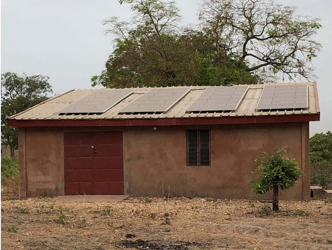
Immagine 23: La casetta dei pannelli solari. Foto scattata il 28/02/2019
