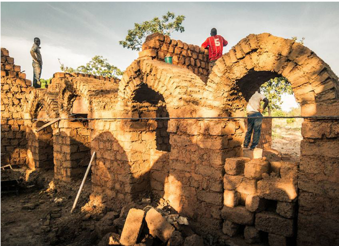
Immagine 15: Il refettorio del modulo 2 terminato. Foto Roof4life.
