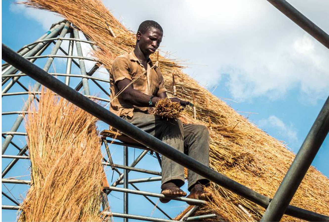
Immagine 16: Un operaio del cantiere di Cape Birim alla prese con la copertura in paglia. Foto di Roof4life.
