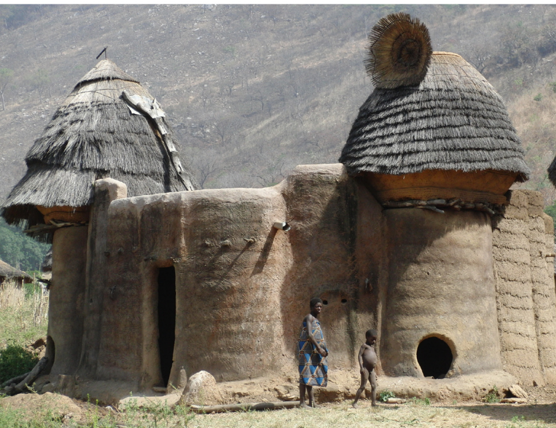
Immagine 20 : I granai circolari con la copertura in paglia apribile. Foto di Yves Regaldi.
