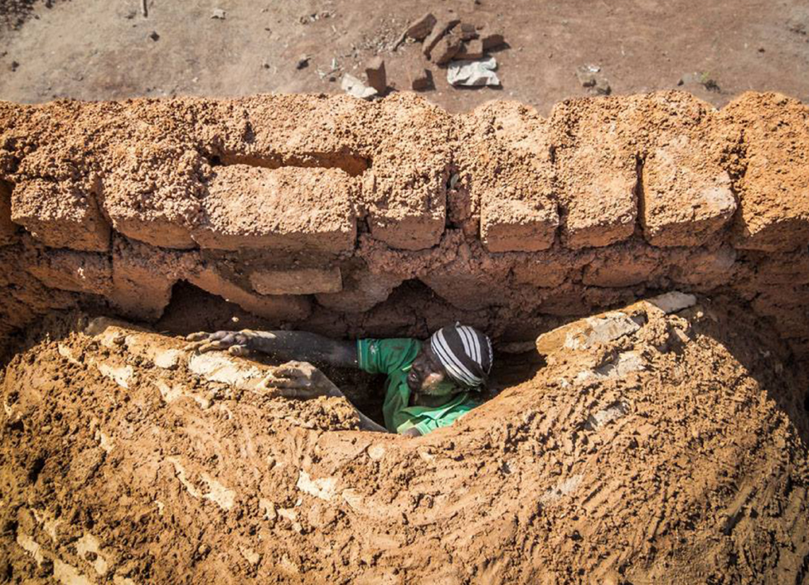
Immagine 21: La chiusura della volta nubiana nel refettorio del modulo 1. Foto di Roof4life
