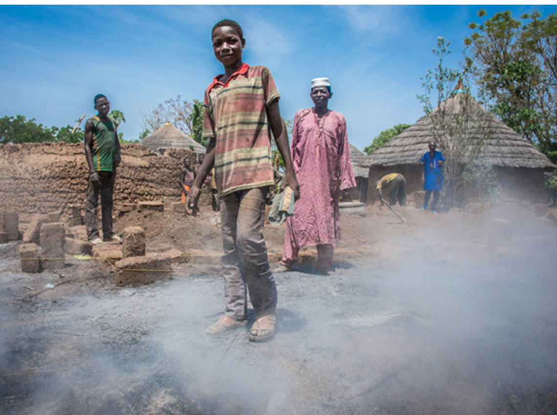
Immagine 3: Bambini al lavoro nella costruzione di una casa. Foto di Marco Bottani. 2013
