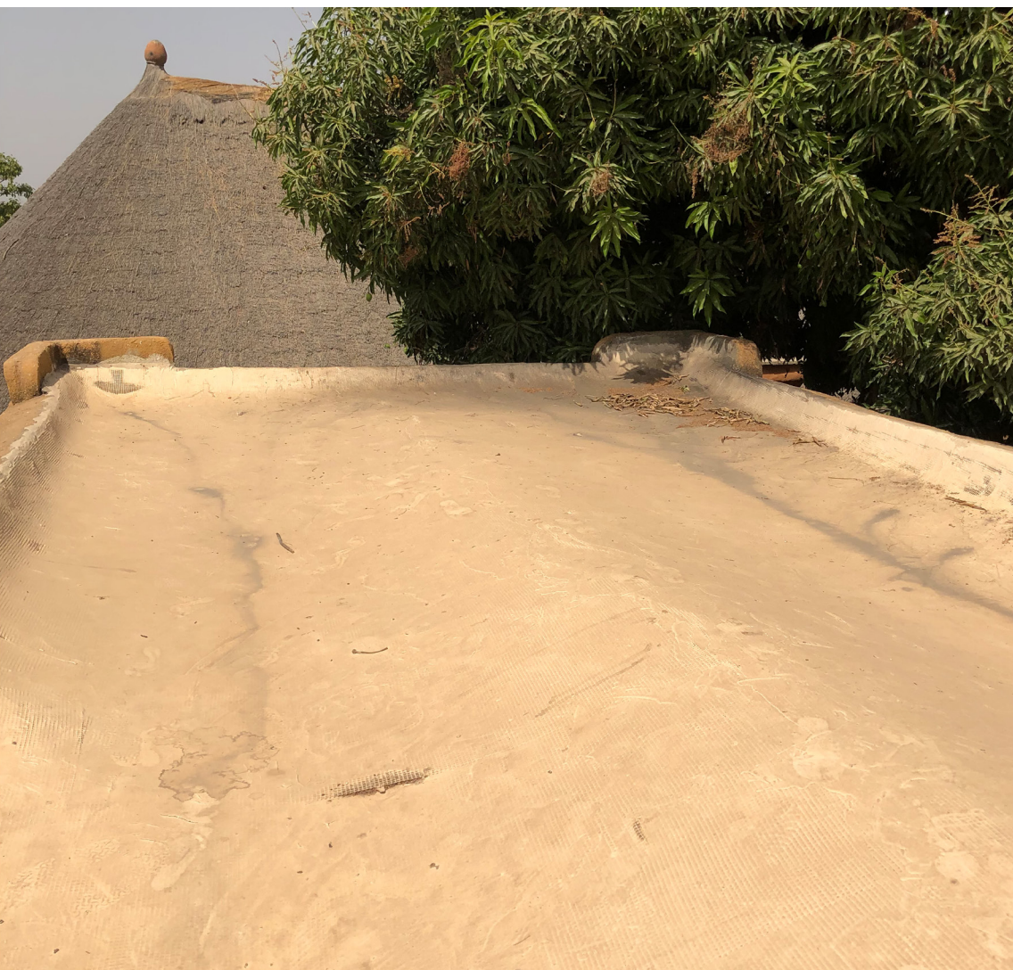
Immagine 19: La parte superiore della volta nubiana del refettorio a Cape Birim. Foto scattata il 02/03/2019
