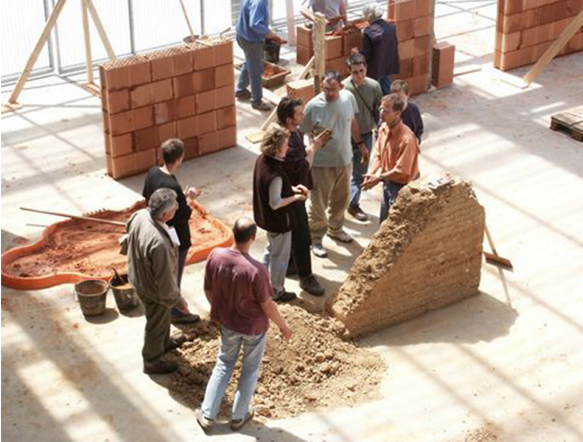
Immagine 4: Dimostrazioni di realizzazione di murature in pisè nel laboratorio di Craterre . Foto craterre.org.
