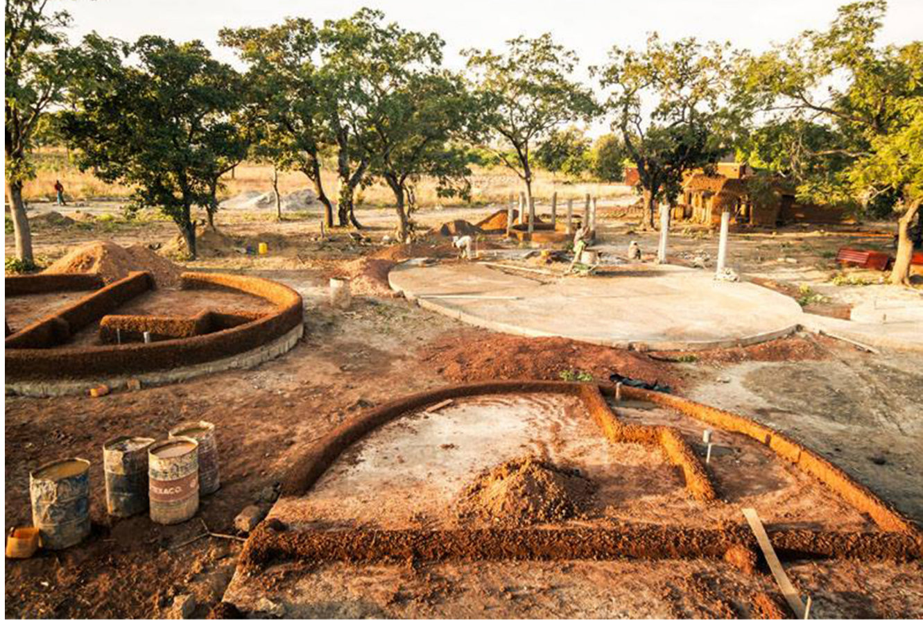
Immagine 8 : Inizio costruzioni della Maisonette con la tecnica Bauge. Foto di Roof4life.
