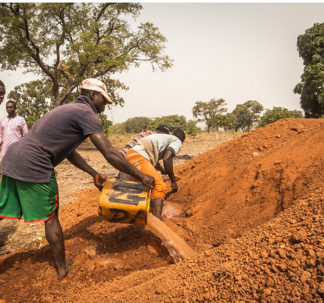
Immagine 4: La preparazione dell'impasto di acqua e argilla al villaggio Cape Birim. Foto di Roof4life.
