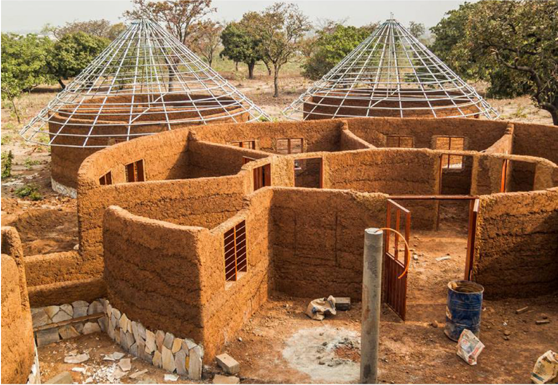
Immagine 11: Cantiere per la realizzazione della prima Maisonette. Foto Roof4life.
