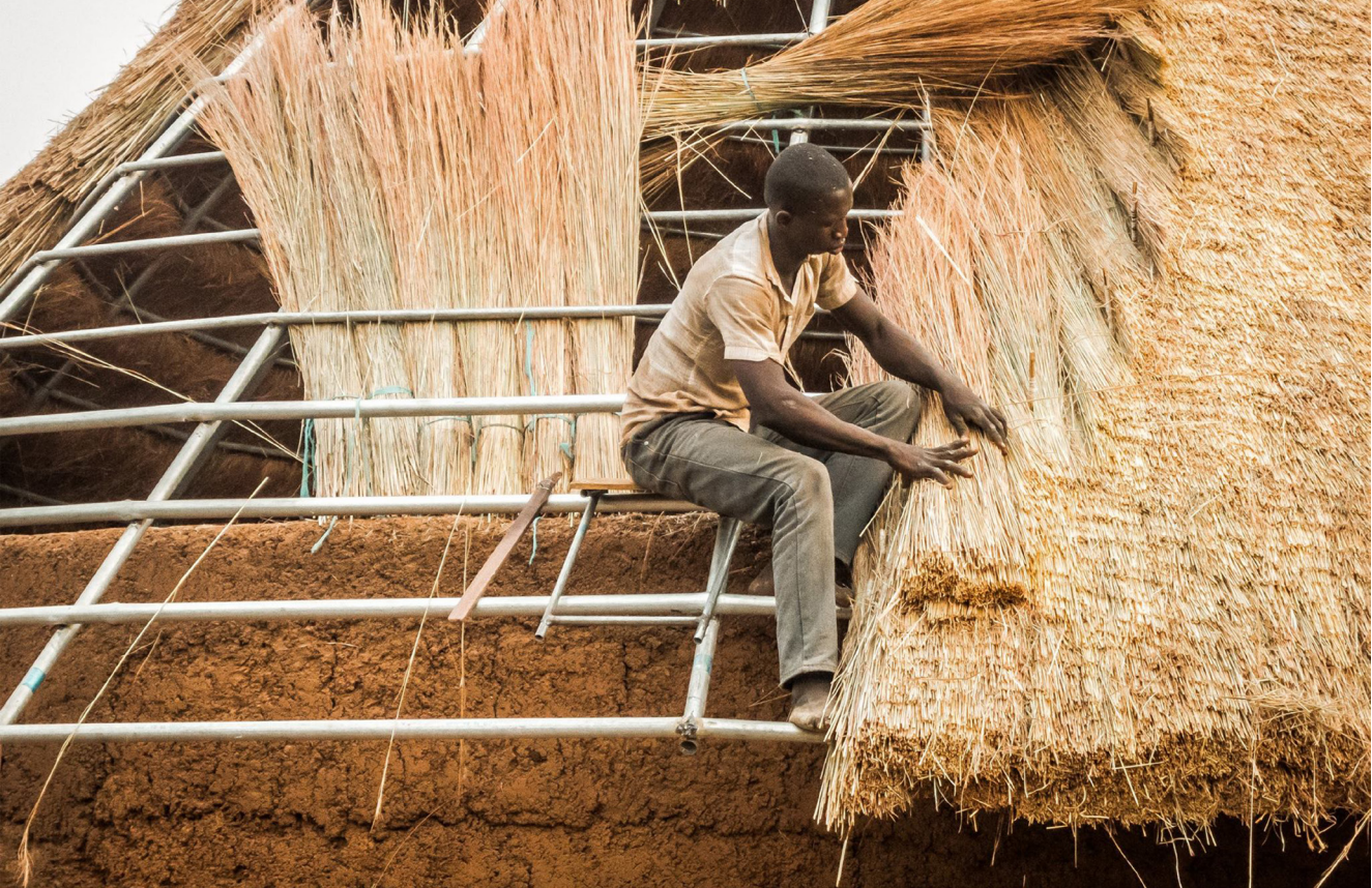
Immagine 17: Un operaio del cantiere di Cape Birim alla prese con la copertura in paglia. Foto di Roof4life.
