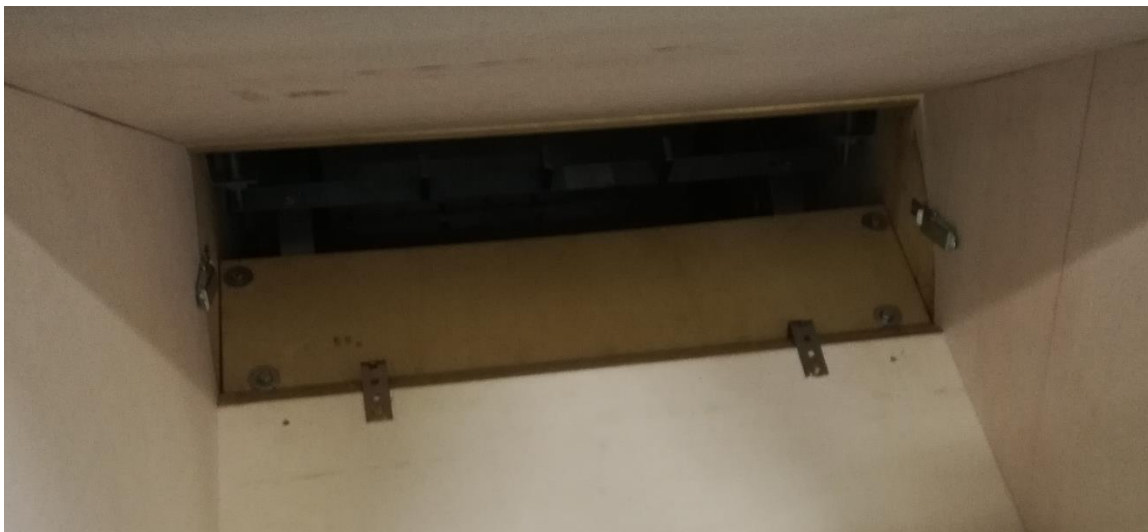
Figura 40 Dispositivi di chiusura a ginocchiera – montaggio interno
