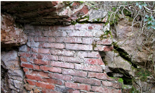
9. Vista di dettaglio sull'adeguamento laterizio all'ingresso del ricovero 405
