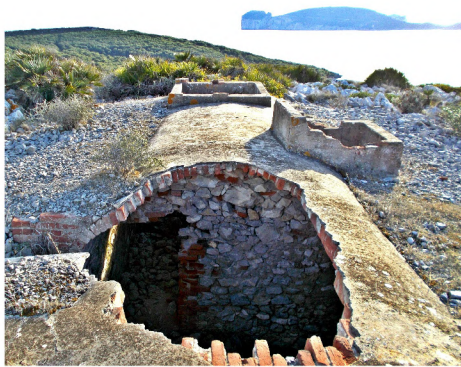
16. Vista della copertura della ricovero 707, in parte crollata
