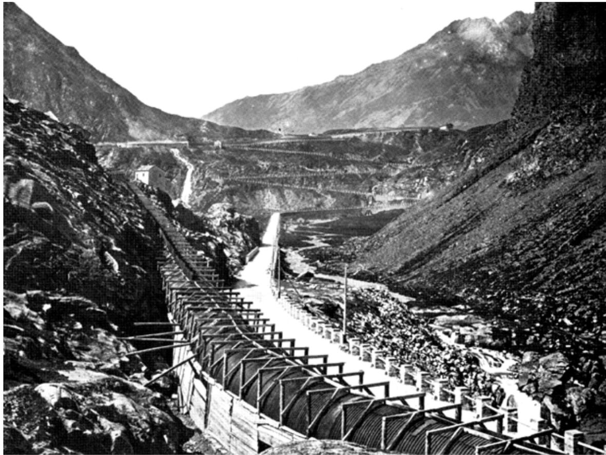
*Fig. 28 - Fotografia della copertura della strada ferrata.
