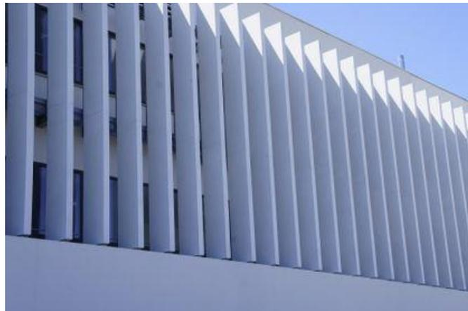
Figura 6 – Frangisole verticale fisso. <sup>7</sup>
