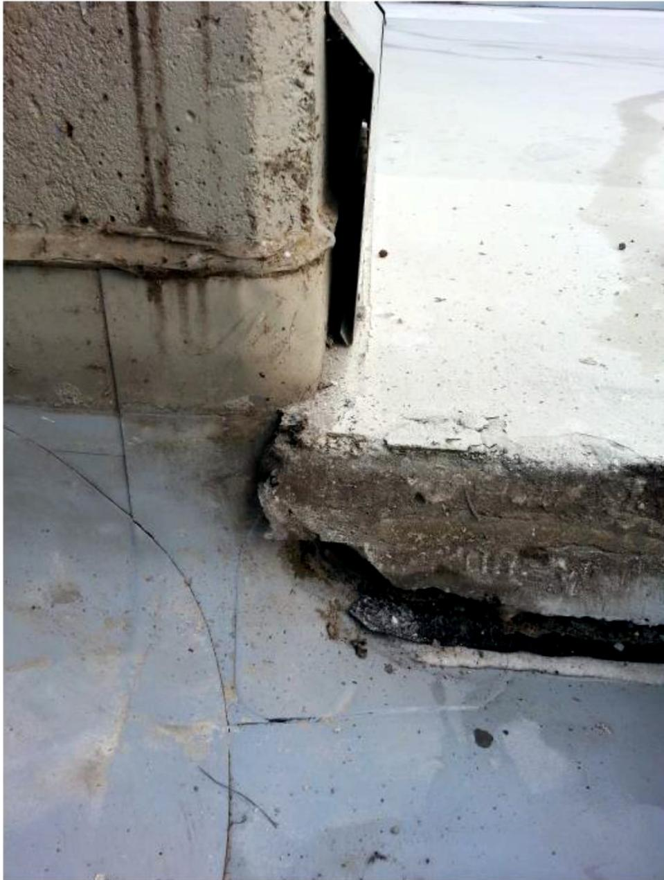
Il “*contro tubo*” inserito all’interno del “*messicano*” di raccordo tra guaina e scarichi non garantisce lo scarico dell’acqua raccolta dalla guaina al di sotto della pavimentazione causando il ristagno d’acqua sull’impermeabilizzazione che contribuisce ad accentuare gli effetti di dilatazione dovuti a gelo e disgelo.
