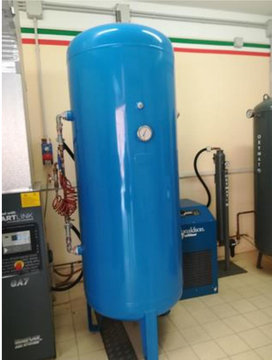
*Figura 31. Serbatoio che accumula aria*
