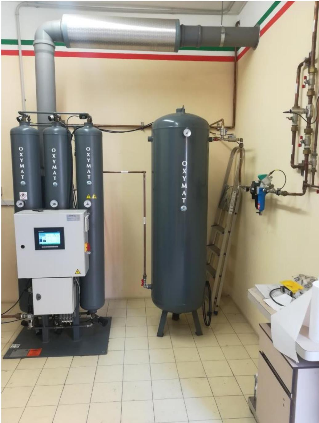
**Figura 33.** Serbatoio che contiene ossigeno
