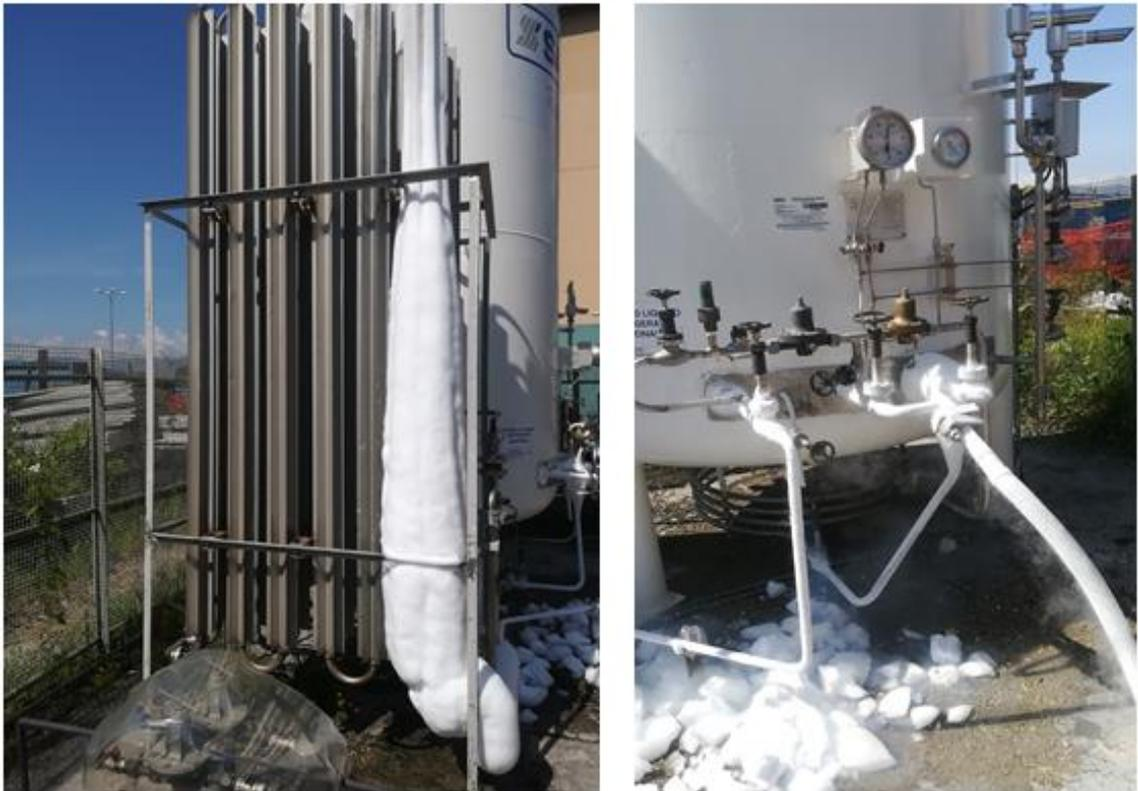
**Figura 6.** Particolari del riscaldatore atmosferico e serbatoio criogenico fisso (Rivoli)
