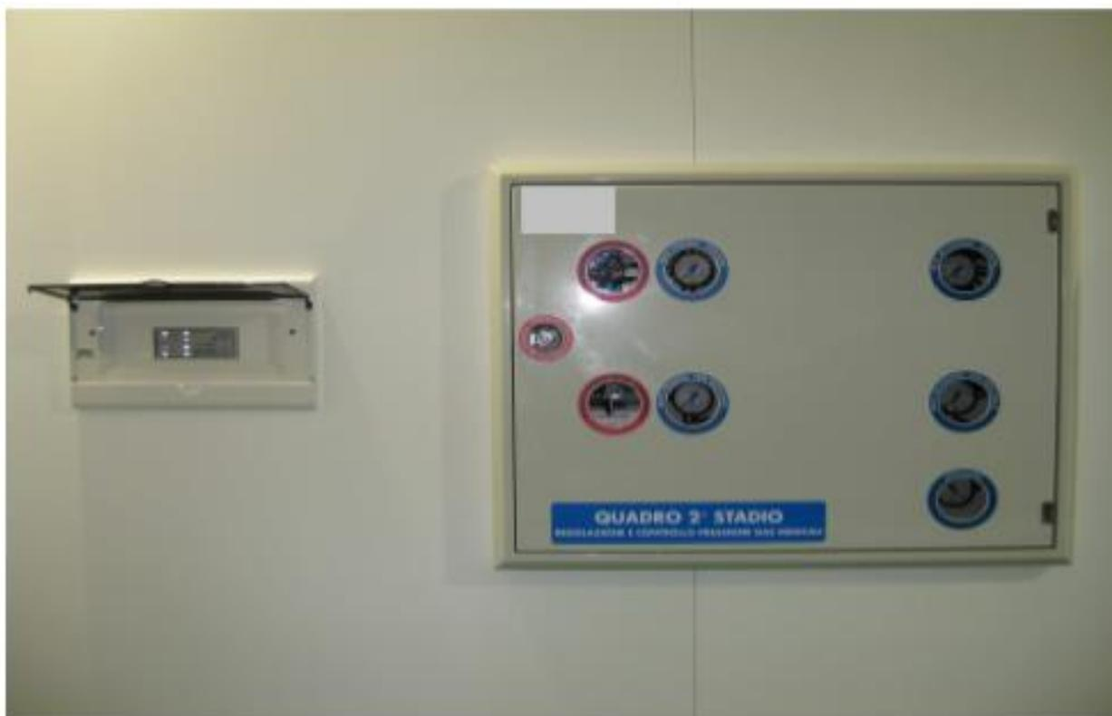
**Figura 14.** *Quadro di riduzione di II stadio con sistema di allarme*
