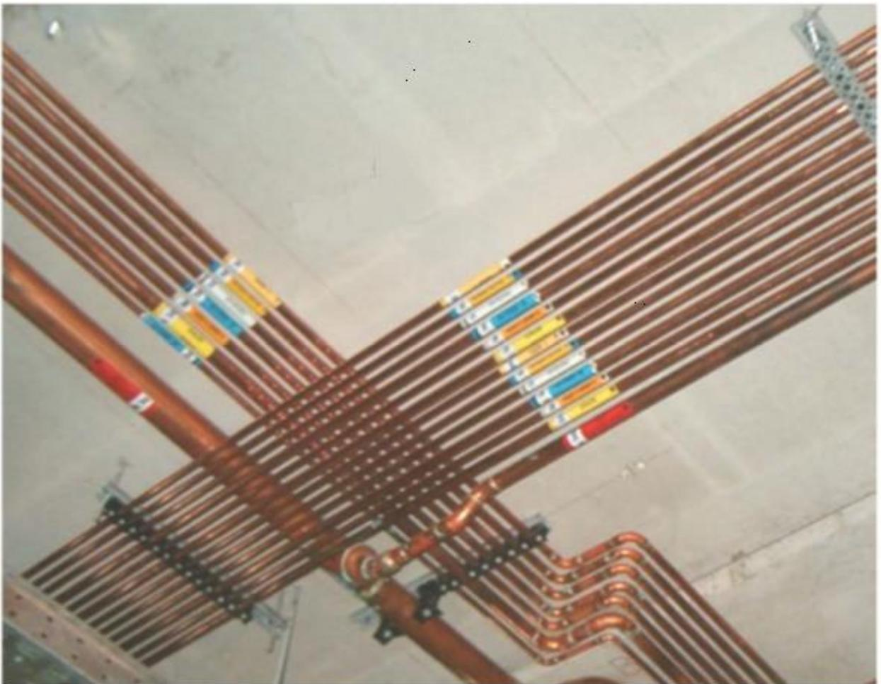
**Figura 13.** Tubi in rame con apposta l'etichetta del materiale che contengono
