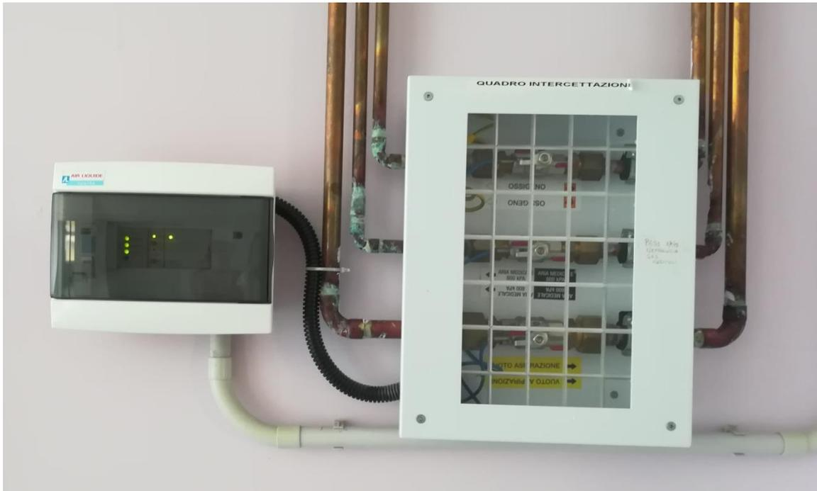
Figura 12. Quadro d'intercettazione e sistemi di allarme
