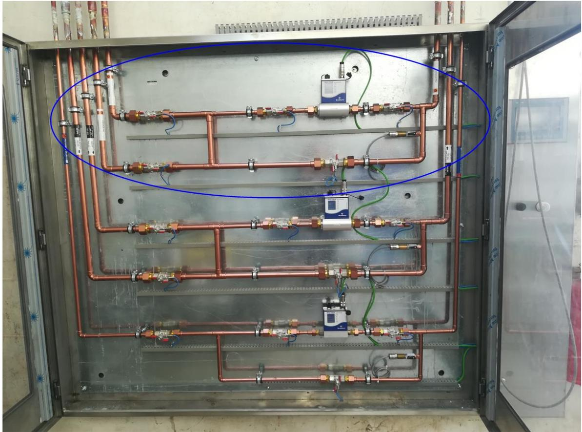
**Figura 20.** *Quadro riduttore ad inversore automatico (la parte cerchiata è quella che riguarda l'ossigeno)*
