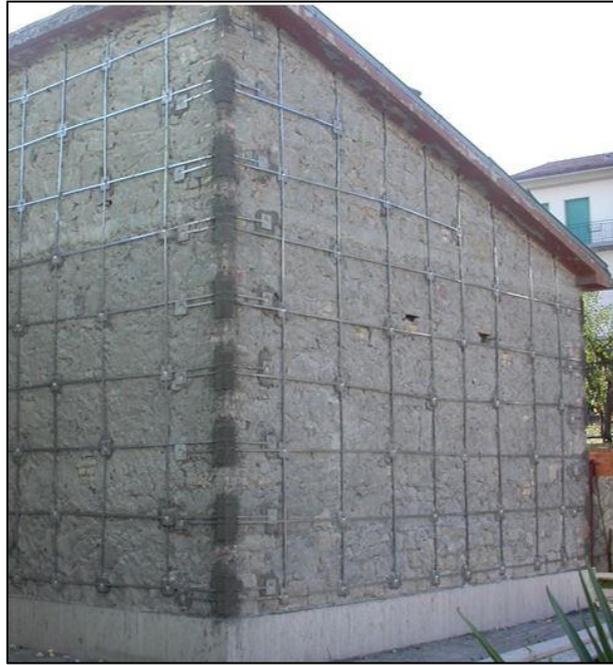
*Fig. 7.16: esempio di rinforzo CAM su pareti perimetrali.*
