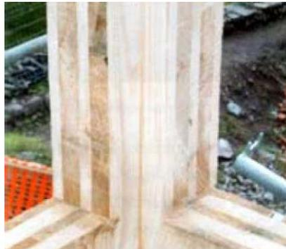
*Figura 54 Sistema a pannelli di legno massiccio.*
