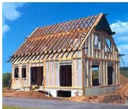
Figura 57 Sistema a telaio.
