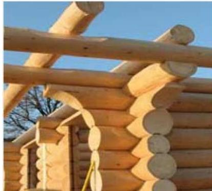
*Figura 53 Sistema a blocchi massicci*
