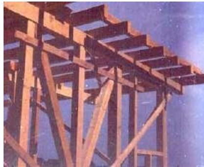
Figura 56 Sistema a traliccio.
