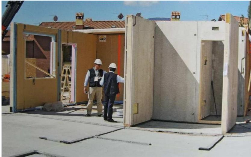
*Figura 82 Assemblaggio di pannelli platform frame con predisposizioni impiantistiche.*
