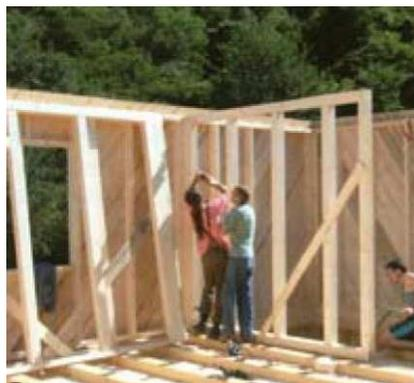
*Figura 55 Sistema ad ossatura.*
