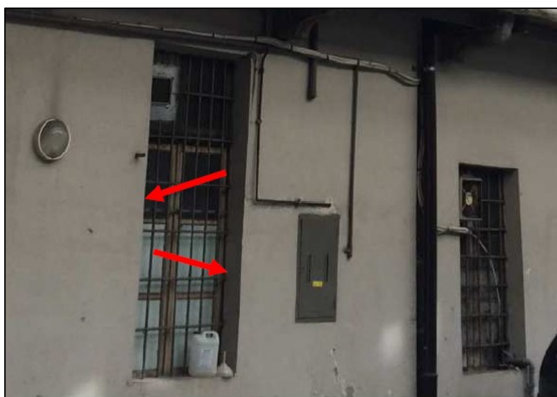
Figura 3.2.4 – Rilievo fotografico – serramento facciata su cortile interno
