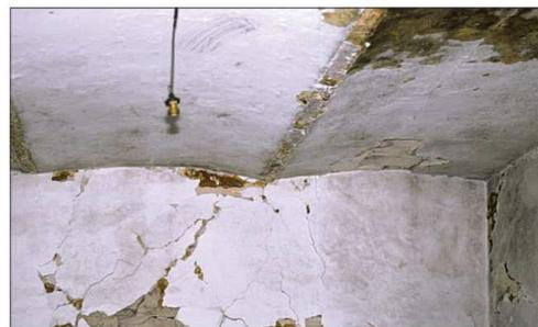
Solaio con travi di ferro a voltine.
