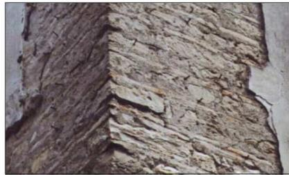
Fig. 2.7 Abaco delle murature irregolari, sezione 3.1A.
