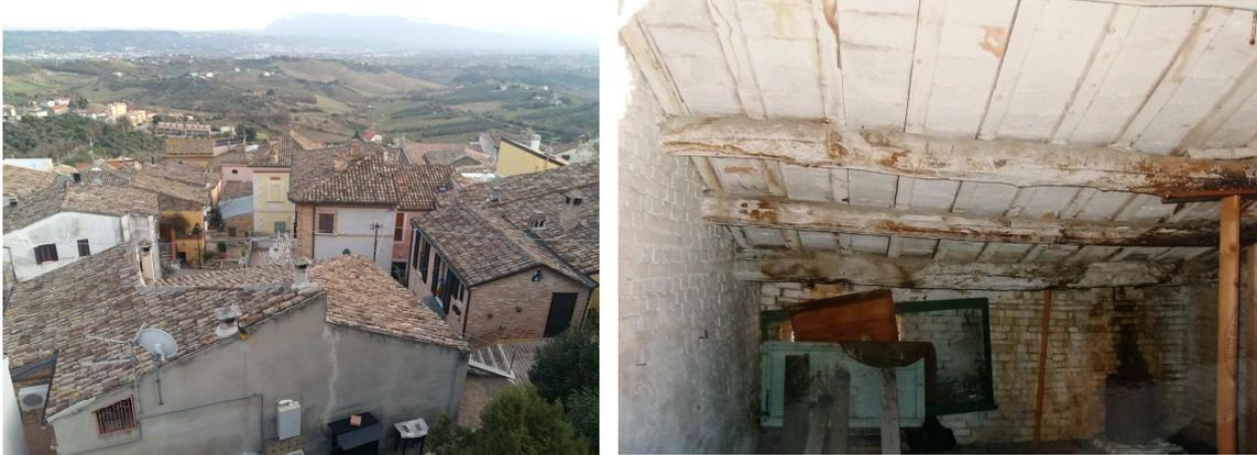
Fig. 3.19 A sinistra, scorcio delle coperture nel comparto C01\_MUR1. A destra, copertura con orditura principale disposta longitudinalmente alla pendenza della falda.
