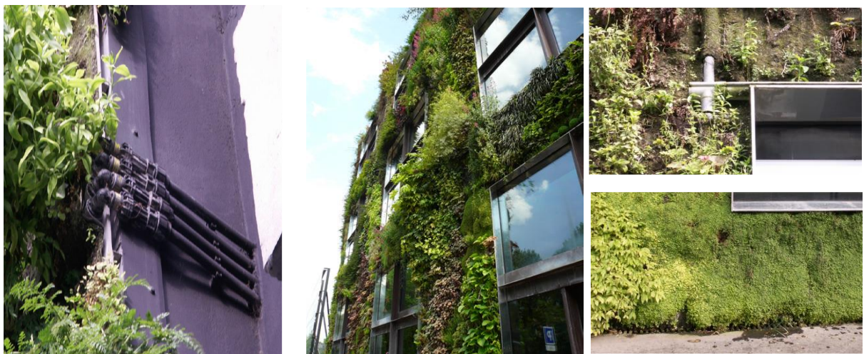
FIGURA 7_A. UNO DEI COLLETTORI DEL SISTEMA DI IRRIGAZIONE DEL MUR VEGETAL. ( FONTE:[22])
