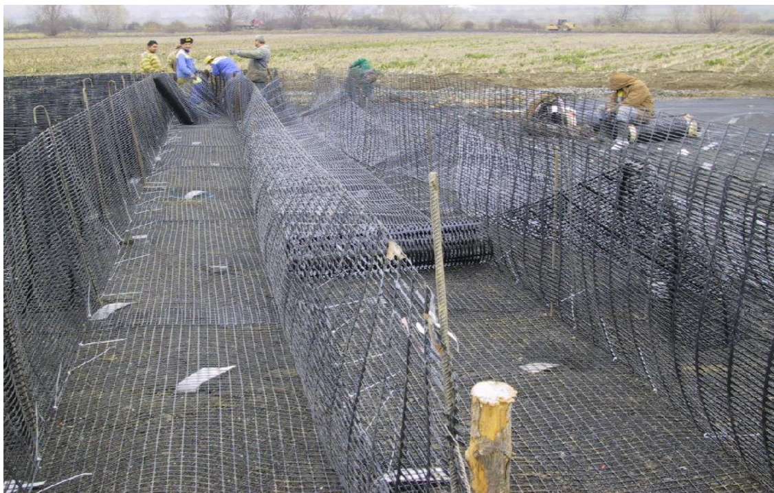
Figura 77 Realizzazione del materasso a geocelle
