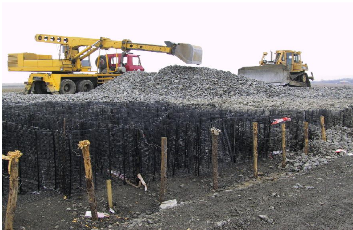
Figura 79 Riempimento del materasso con ghiaia
