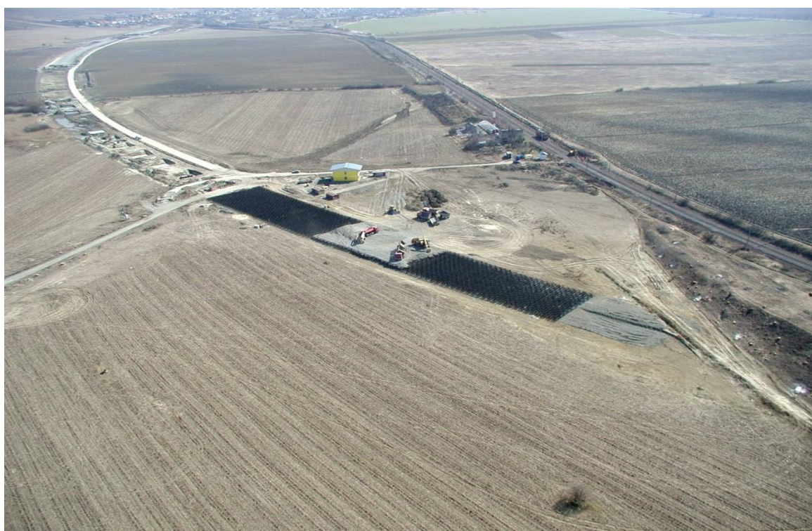
Figura 80 Vista d'insieme del tratto di linea ferroviaria durante la posa del materasso
