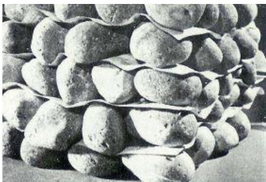
Figura 22 Principi di funzionamento delle terre armate
