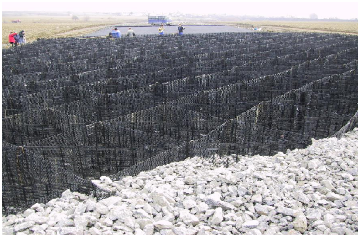
Figura 78 Vista del materasso a geocelle appena realizzato
