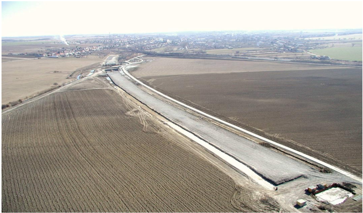
Figura 81 Vista d'insieme della linea ferroviaria dopo il riempimento del materasso con la ghiaia
