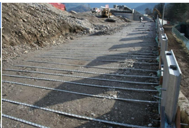
Figura 23 Esempi di strutture in terra armata
