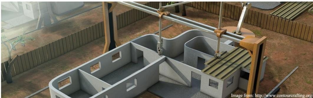
Figura 9 - Esempio di Contour Crafting
