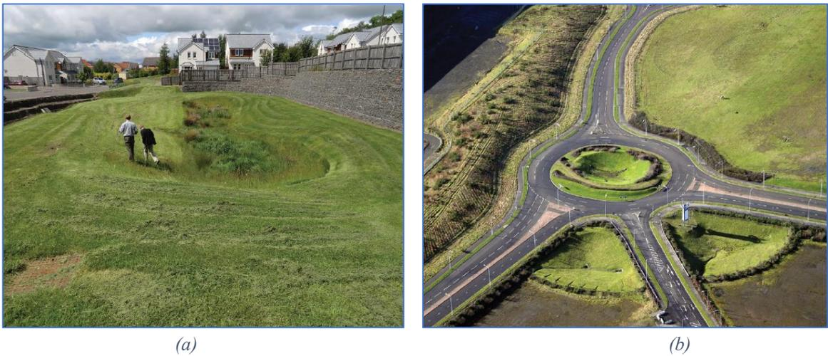
Figura 4.3 Dry Detention System applicato ad uso residenziale nella figura (a) ed applicato in una rotonda stradale (b)
