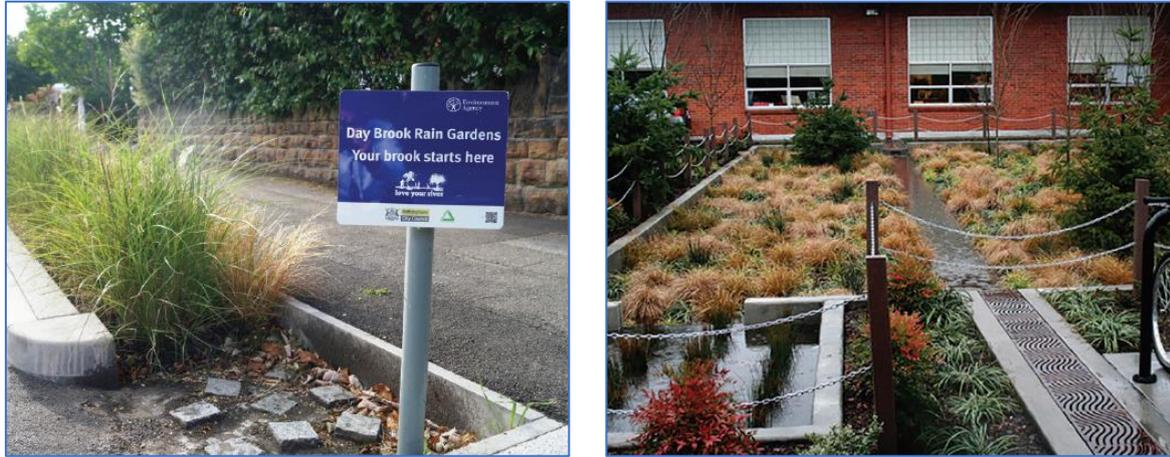
*Figura 4.7 Esempi di bioretention system caratterizzati da barriere per i detriti poste all'ingresso del sistema. Nel primo caso la barriera è ottenuta mediante l'utilizzo di un filtro composto da blocchi di pietra cementati fungono da rete; nel secondo caso l'ingresso nel sistema è preceduto da una vasca che permette la sedimentazione dei detriti più pesanti.*
