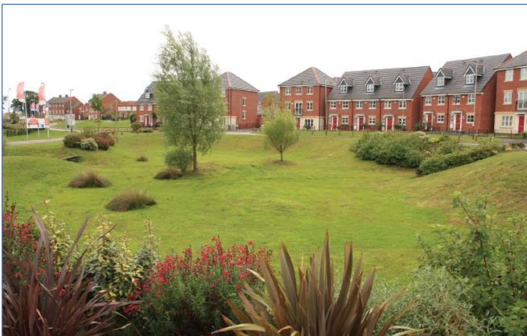
*Figura 4.1* Bacino di detenzione che fornisce un'estesa area di comfort fruibile dalle persone nei periodi in cui non entra in funzione
