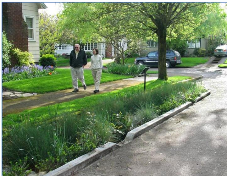
Figura 3.7 Esempio di taglio nei cordoli per favorire il convogliamento delle acque meteoriche all'interno dell'area verde (Fonte: "Low Impact Development: a Design Manual for Urban Areas", Huber J.)
