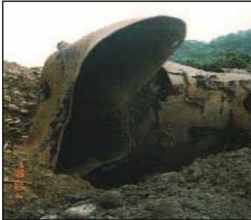
FIGURA 12: TUBAZIONE A SEGUITO DEL TERREMOTO DEL CHI-CHI
