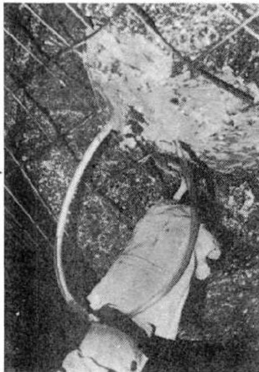
**Figura 1.8 – Applicazione della malta a presa rapida sulla testa del bullone installato su superficie scabra per ovviare al problema della sigillatura (E. Hoek, E.T. Brown - 1980)**
