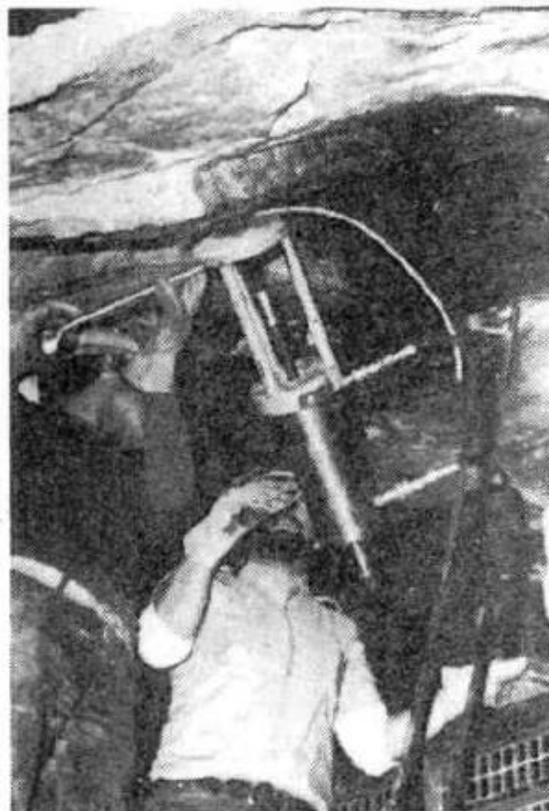
**Figura 1.4 – Tesatura idraulica diretta (E. Hoek, E.T. Brown - 1980)**
