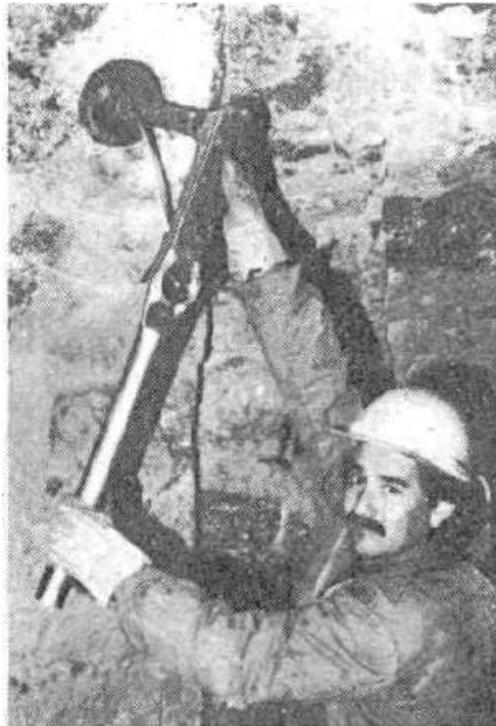
**Figura 1.3 – Chiave dinamometrica impiegata per la tesatura sotto le 10 tonnellate (E. Hoek, E.T. Brown - 1980)**
