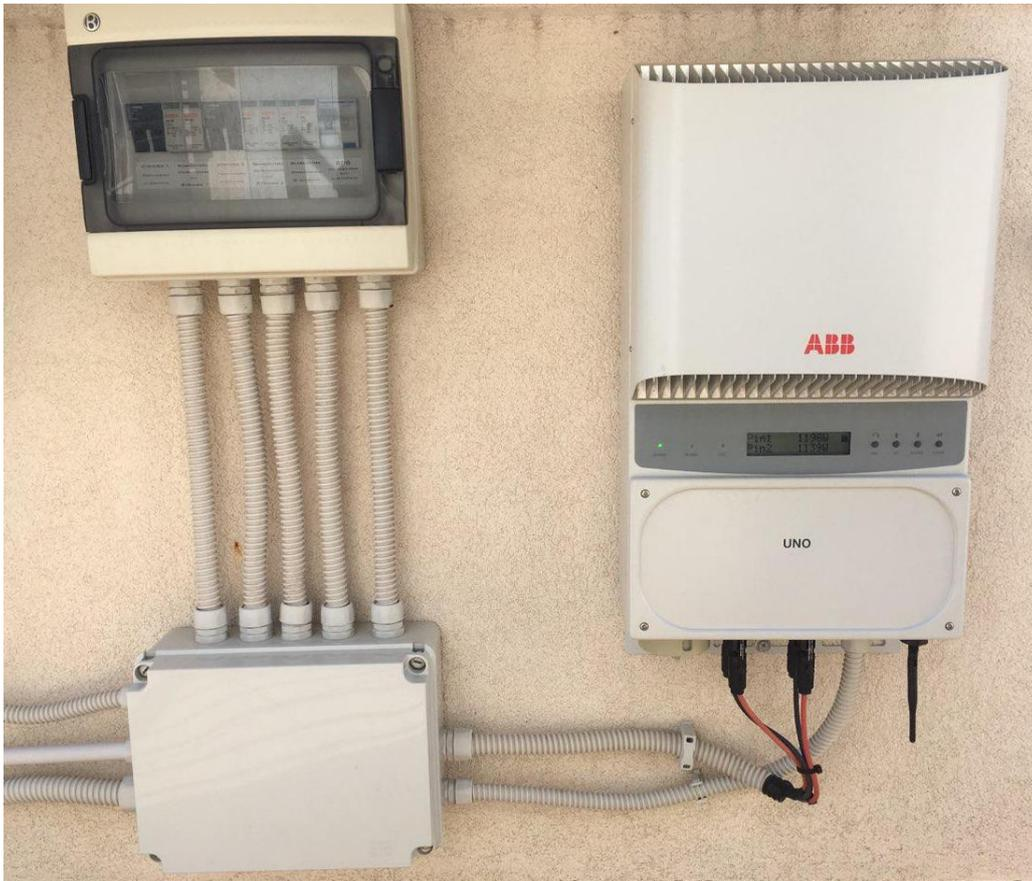
Figura 1.8: Inverter monofase a due ingressi per impianti domestici, completo di scheda di rete per monitoraggio a distanza
