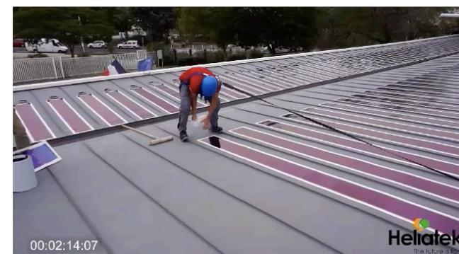
Le varie sequenze di montaggio mostrano quindi quanto sia facile e rapido installare questa particolare tecnologia su coperture esistenti, come si può notare dall'ultima immagine un modulo organico di 5,7 m per 0,32 m viene installato in poco più di 2 minuti senza richiedere nessuno sforzo particolare agli operatori (vantaggio agevolato dall'estrema leggerezza del prodotto).
