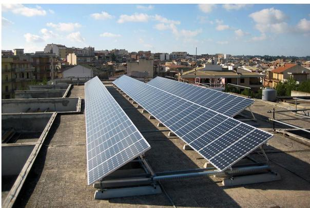
*Figura 2.1 esempio di impianto fotovoltaico in silicio monocristallino non integrato (fonte: [www.impelsnc.it](http://www.impelsnc.it))*
