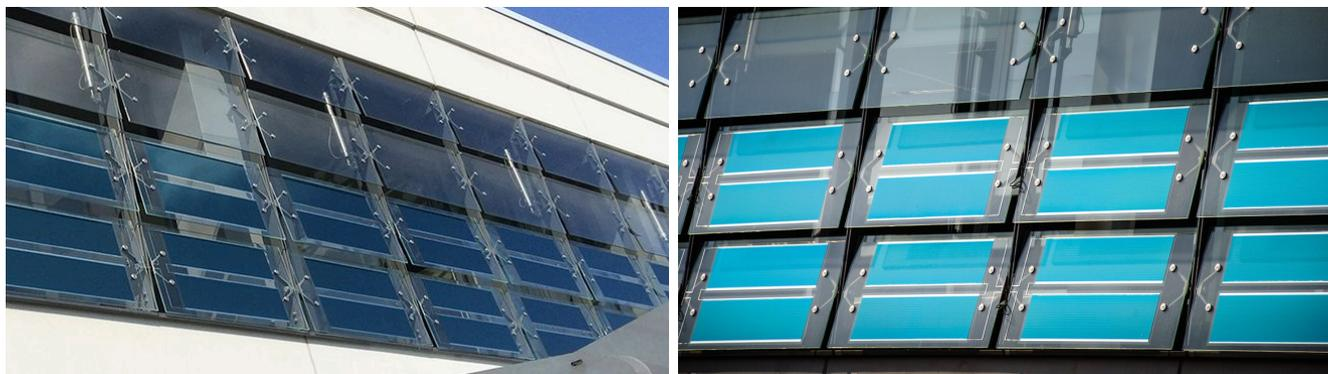
Figura 3.21 Installazione OPV (fonte: Heliatek)
