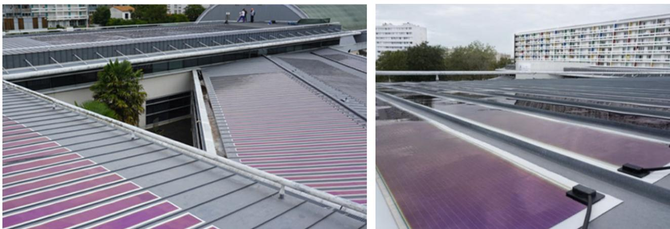
Figure 3.18 installazione OPV (fonte: Heliatek)
