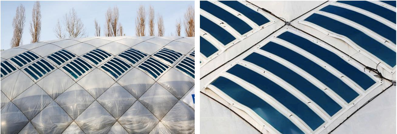
Figure 3.23 installazione OPV (fonte: Heliatek)
