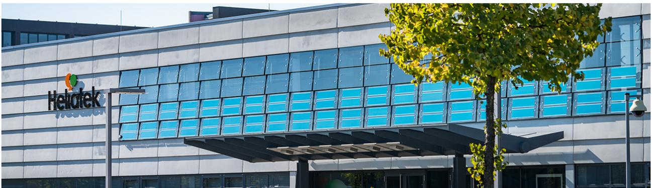
*Figura 4.1 Vista della vetrata in cui sono stati implementati i moduli organici racchiusi all'interno dei pannelli di vetro ( fonte: [www.heliatek.com](http://www.heliatek.com))*
