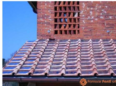
Figure 2.33 esempio di tegola fotovoltaica (fonte: Fornace Fonti srl)
