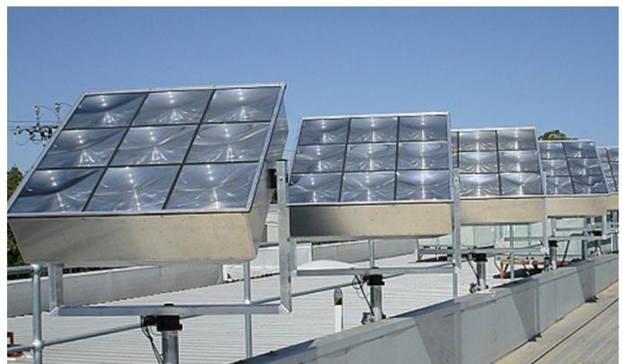
*Figura 2.2 esempio di impianto fotovoltaico a concentrazione non integrato (fonte: [www.consulente-energia.com](http://www.consulente-energia.com))*
