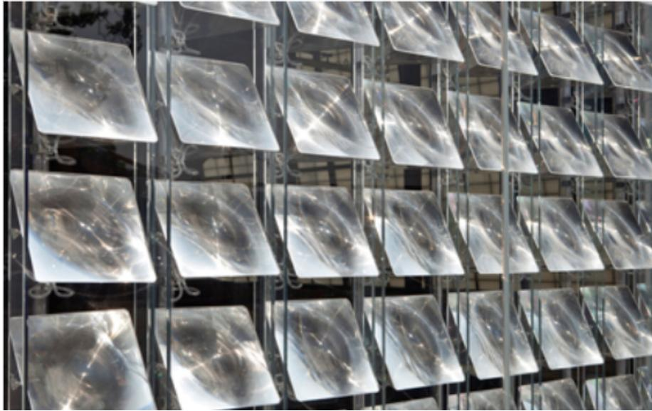
Figura 3.3 installazione BICPV (fonte: [www.case.rpi.edu](http://www.case.rpi.edu))
