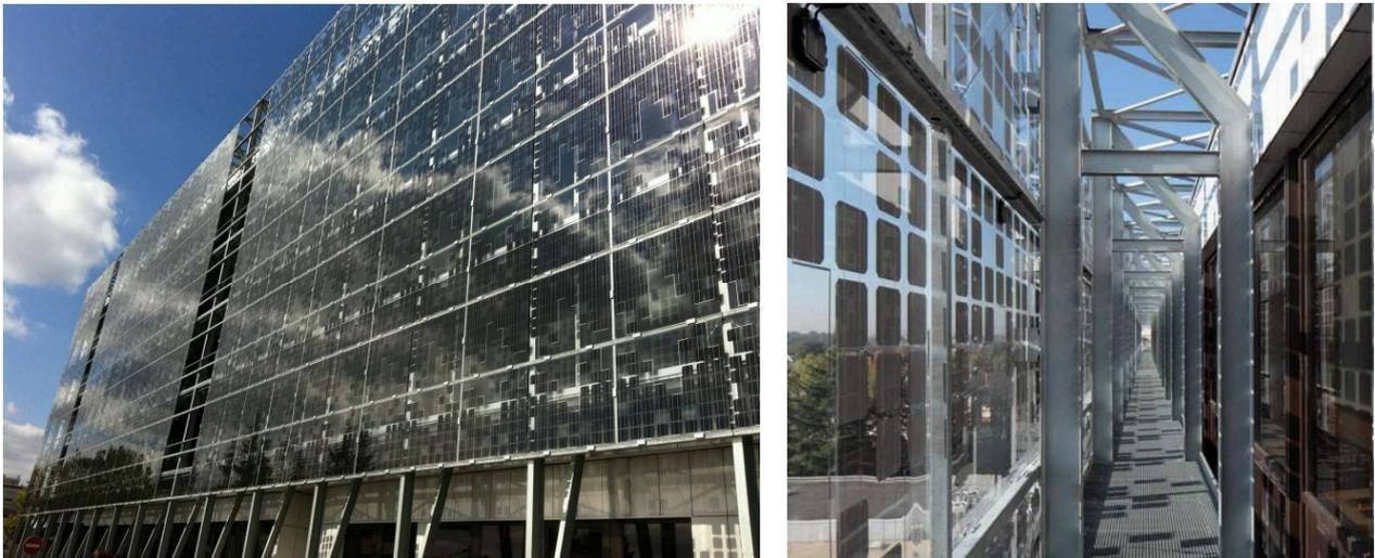
Figure 2.28 esempio di facciata a doppia pelle con all'esterno inglobate celle al silicio monocristallino (fonte: www.bipv.ch)
