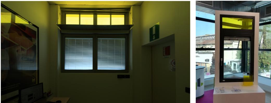
Figure 3.10 esempi di applicazioni dei pannelli LSC realizzati da ENI per l'implementazione su finestre (fonte: eniday.com)
