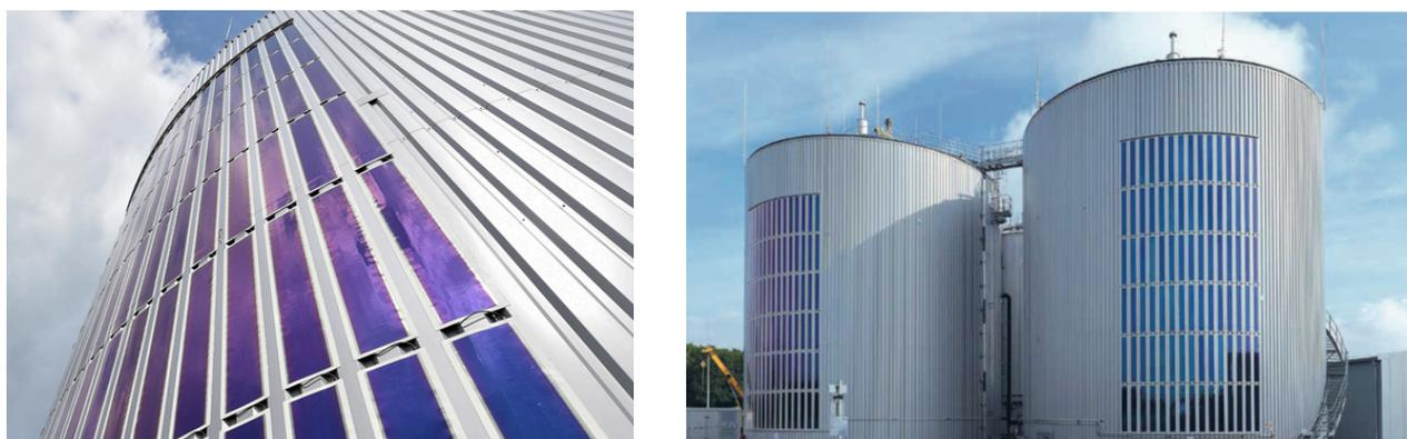
Figure 3.19 installazione OPV (fonte: Heliatek)
