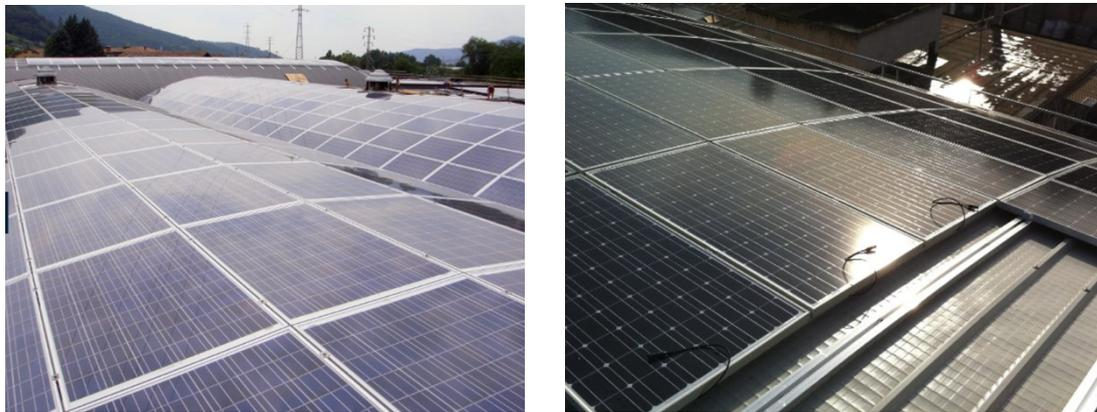
Figure 2.16 pannelli al silicio cristallino su coperture metalliche di capannoni industriali (fonte: [www.alubel.com](http://www.alubel.com))
