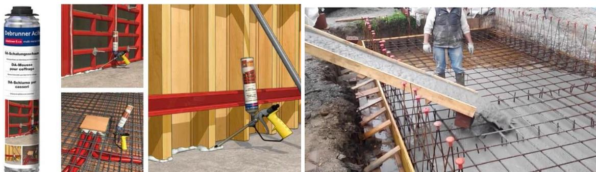
Figura 92: preparazione casseforme con la schiuma poliuretanic (sinistra) e pompaggio calcestruzzo autocompattante (destra)
