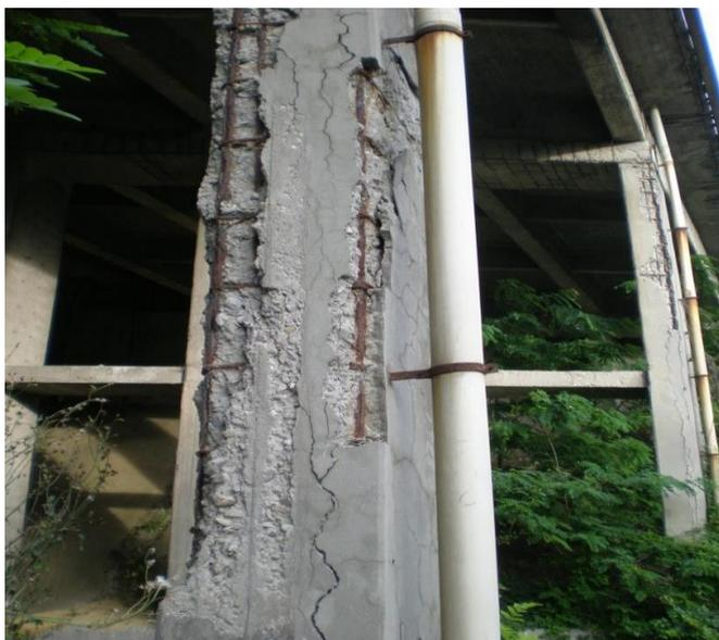
Figura 19: degrado promosso da carbonatazione
