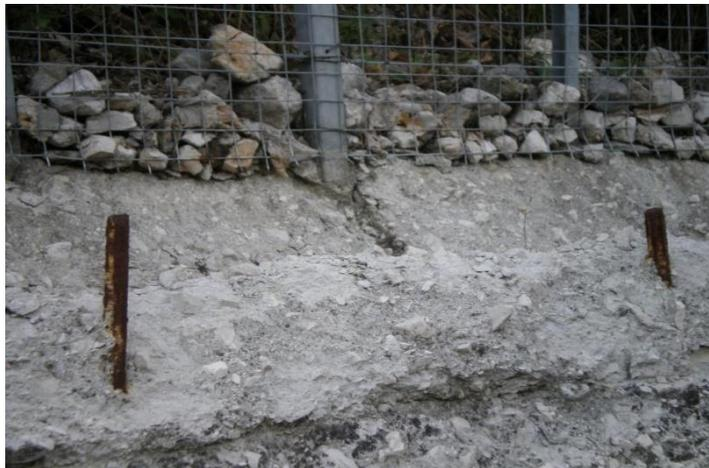
Figura 21: degrado per cicli gelo/disgelo
