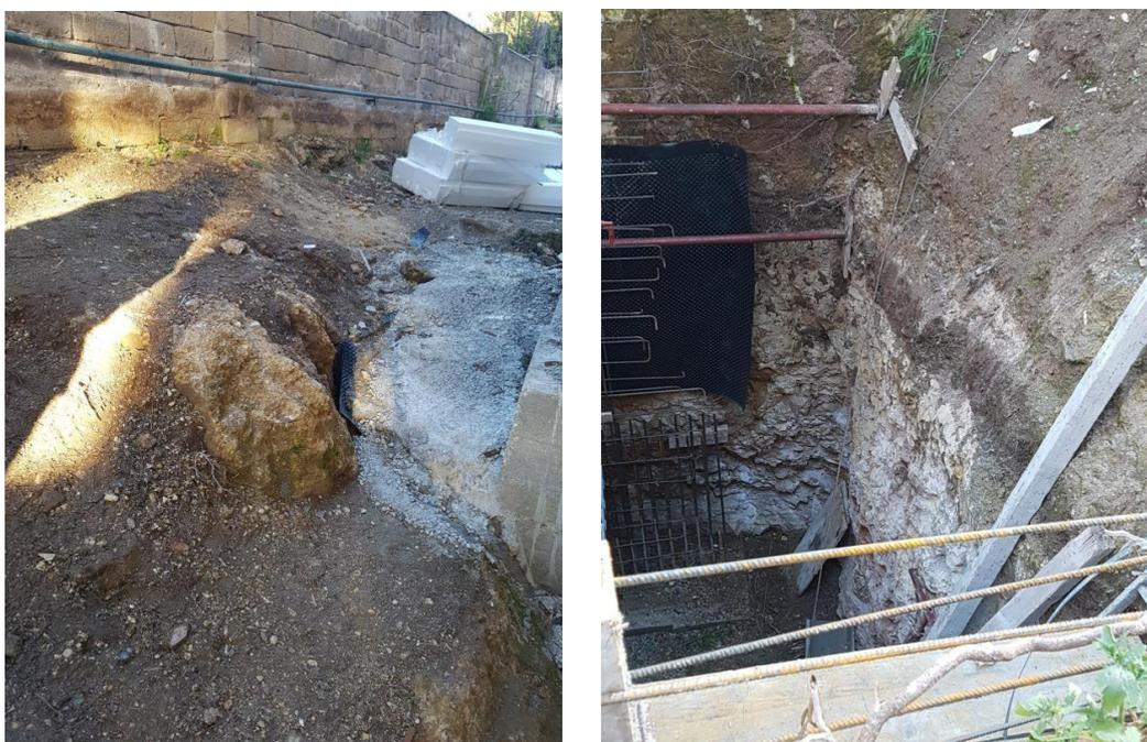
*Figura 83: affioramento di calcareniti e scavo in terreno adiacente*
