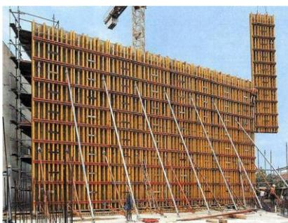
Figura 71: esempio di casseforme
