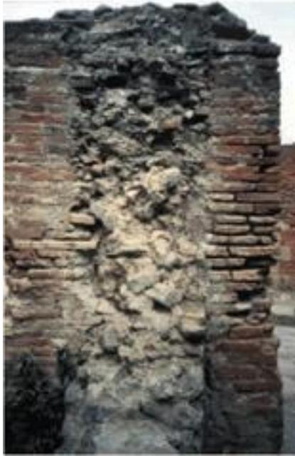
Figura 22: muro in calcestruzzo romano che mostra tra i paramenti in mattone il conglomerato a base di malta e grossi rottami di pietra o mattone (Pompei)
