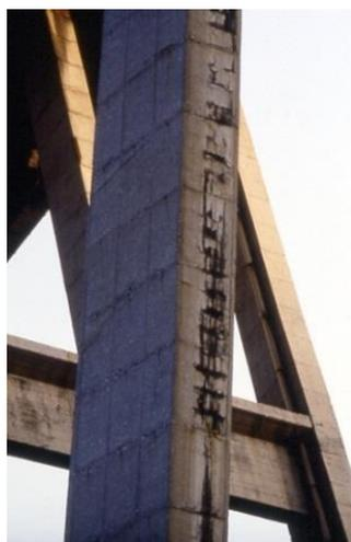
*Figura 1: espulsione del copriferro a seguito della corrosione dei ferri di armatura*
