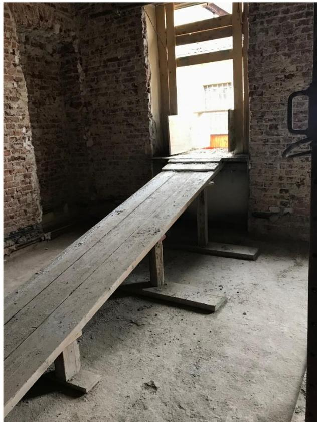
Figura 37. Pedana di scarico detriti e tavole di legno di protezione
