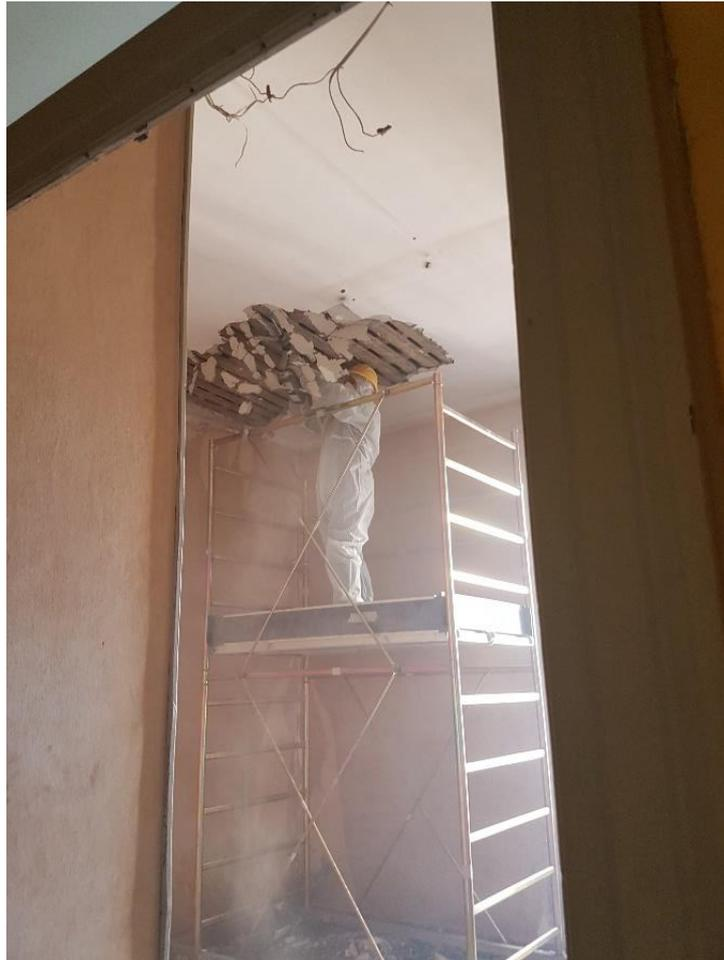
*Figura 43. Rimozione controsoffitto*
