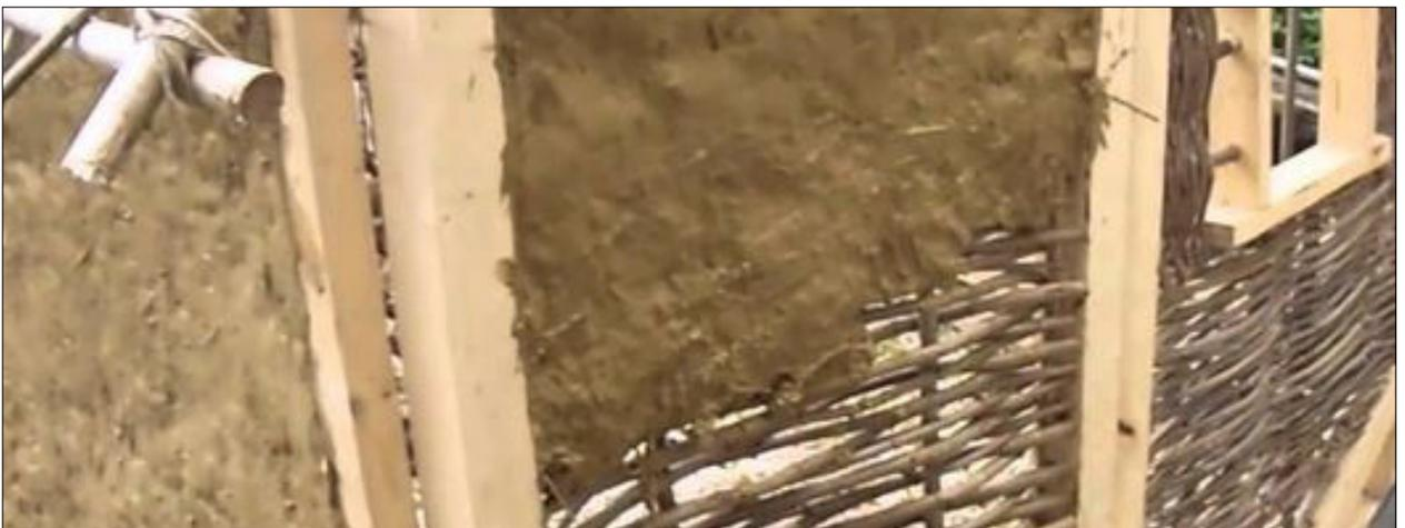
FIG 3. 3. 3. 2. 2\_ METODO DI POSA DEL TORCHIS
