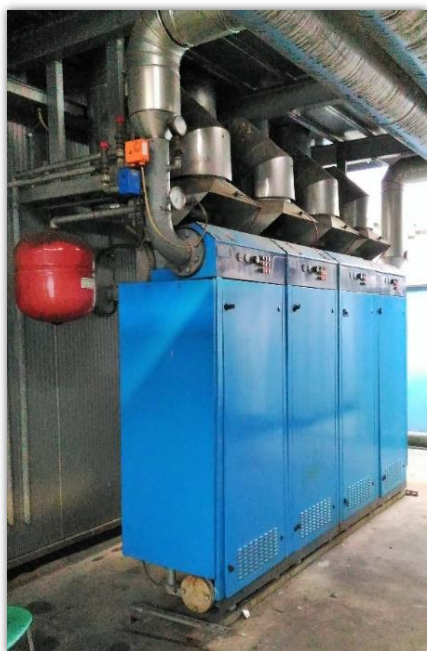
Figura 3.9 - Teatro della Concordia, gruppo caldaie in locale tecnico a cielo aperto
