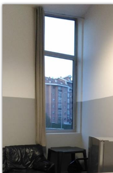
Figura 3.7 - Teatro della Concordia, dettaglio infissi camerini
