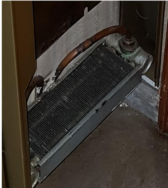
*Figura 3.32 Dettaglio batteria termoconvettore*
