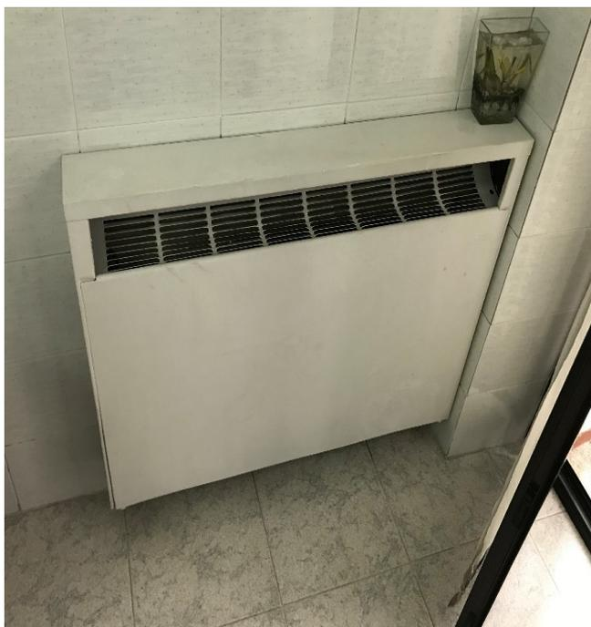
Figura 3.29 Termoconvettore senza serranda
