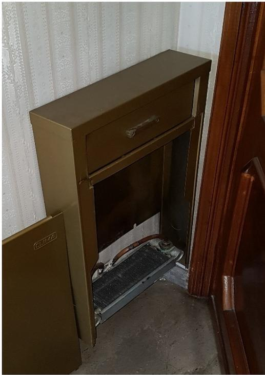
*Figura 3.31 Termoconvettore aperto*
