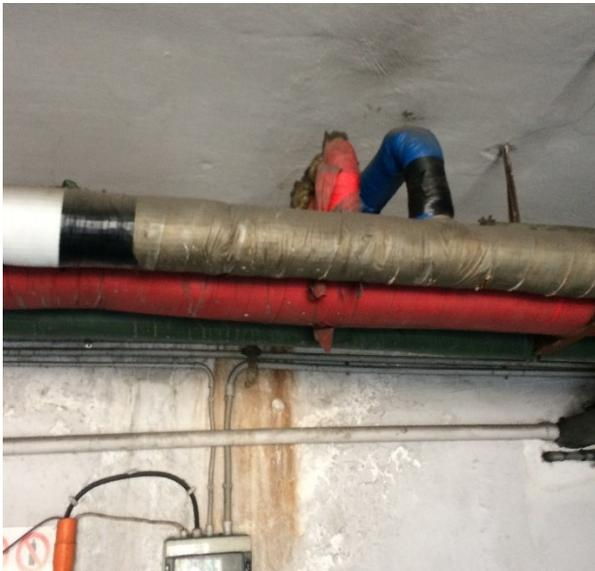
Figura 3.17 Stato isolante stacco 35-bis
