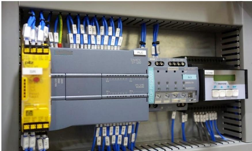
**Figura 72: strumento PLC di misura dell'energia elettrica prodotta**
