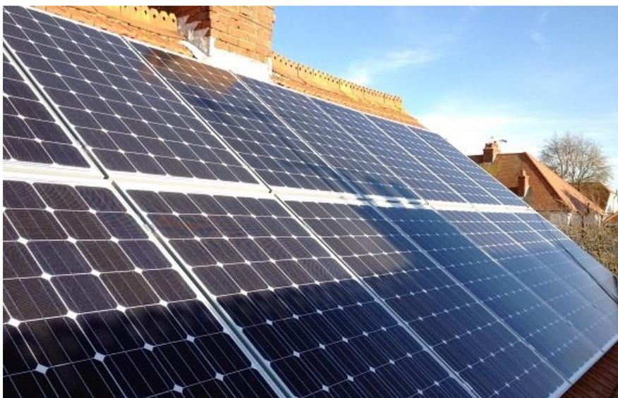
*Figura 46. Esempio di ombreggiamento sui moduli*
