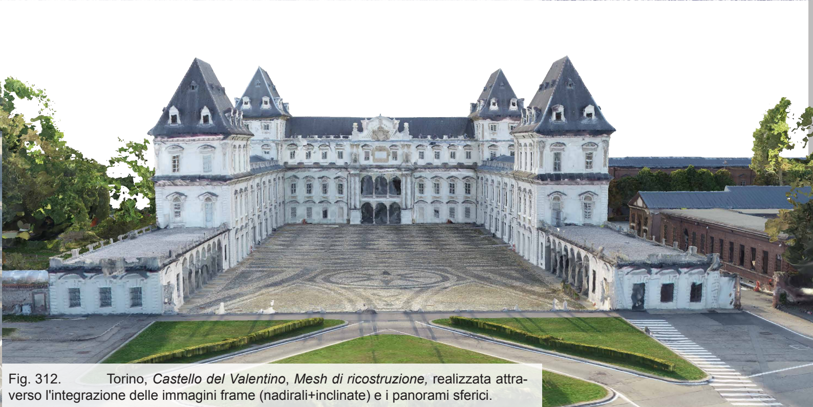
Fig. 311. Torino, Castello del Valentino , Mesh di ricostruzione , realizzata attraverso l'integrazione delle immagini frame (nadirali+inclinate) e i panorami sferici.
