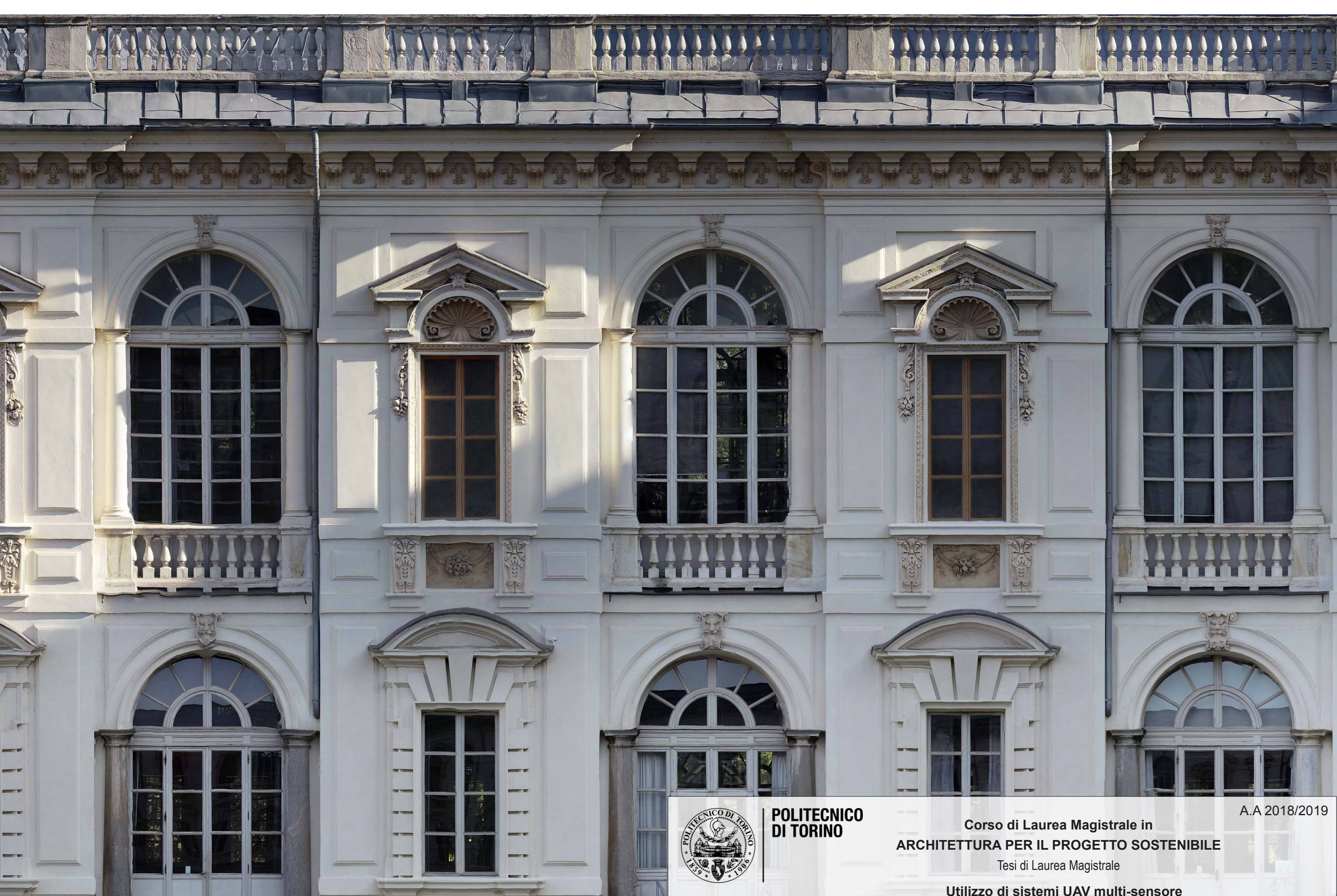
Torino, Castello del Valentino. Porzione dell'ortofoto realizzata attraverso fotogrammetria UAV con l'ausilio delle immagini sferiche (fuori scala).
