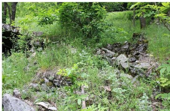
porzione ancora in piedi del muro controterra del fabbricato 4, in cui emerge la tipologia di pietre utilizzate e la diversa granulometria.
