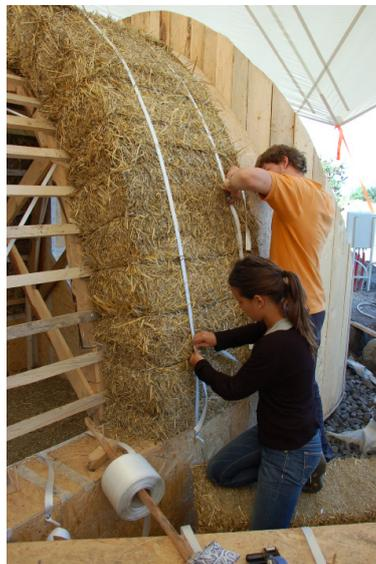
Inserimento chiave di volta e ancoraggio delle balle di paglia tramite cinghie
