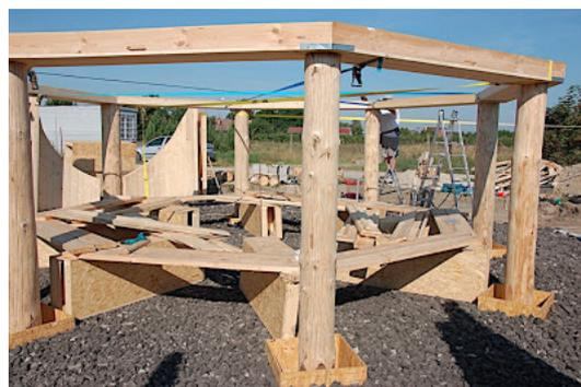
Canaline interne alla corona di legno e assemblaggio della struttura principale
