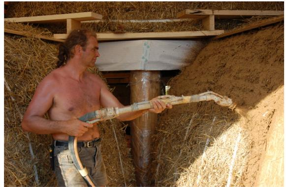
Posa degli intonaci mediante delle pompe
