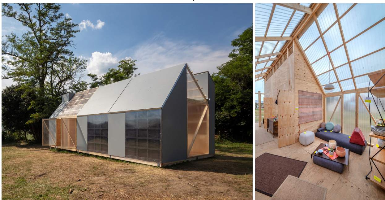
Cabin Modules, esterno ed interno [img. 12-13]
