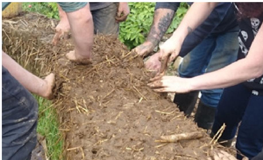
Figura 20: modellazione terra impilata (Fonte: <http://www.cobcourses.com/cob-houses/>)
