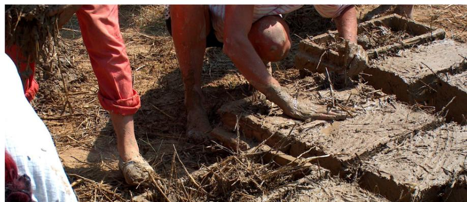
Figura 18: modellazione di blocco in adobe (Fonte: <http://www.pangea-project.org/adobe-houses-case-di-terra-cruda/>)
