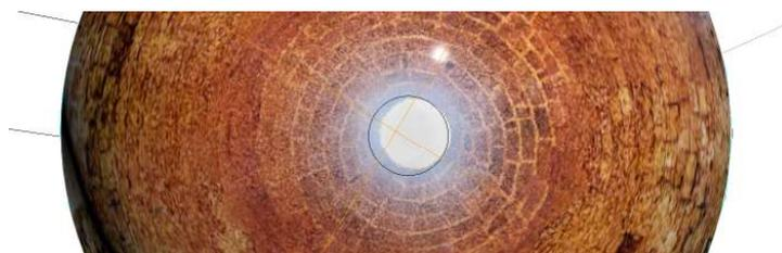
Fig. 150: Dettaglio in pianta della mappatura sferica: il lucernario risulta sfasato dalla sua posizione.
