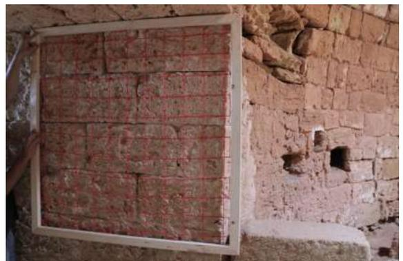
Fig.130.69: Rilievo fotografico - quadrettatura di un campione di muratura dell'apertura a Nord-Est.
