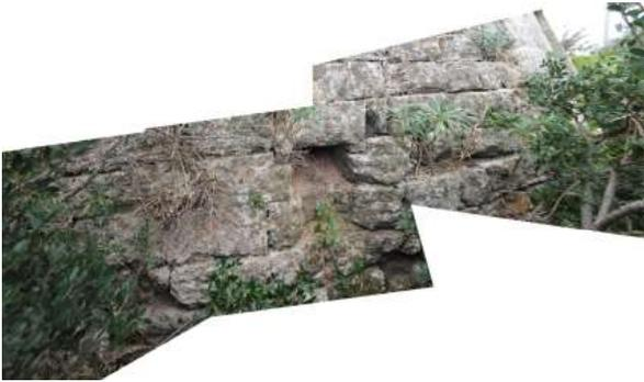
Fig. 103: Rilievo fotografico - dettagli. Feritoia nascosta sotto la vegetazione sulla parete a Nord-Est.
