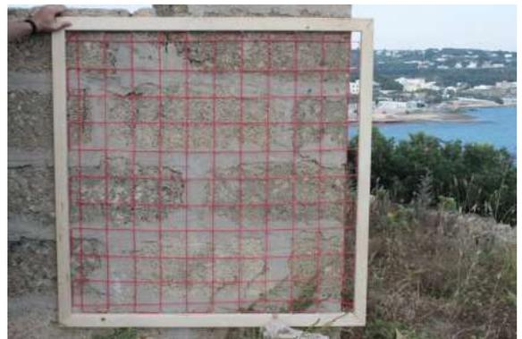
Fig. 130.71: Rilievo fotografico - quadrettatura di un campione di tessitura muraria della trincea esterna.
