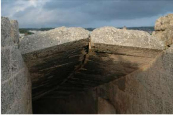
Fig. 124: Rilievo fotografico - dettaglio: arco di scarico del corpo scala.
