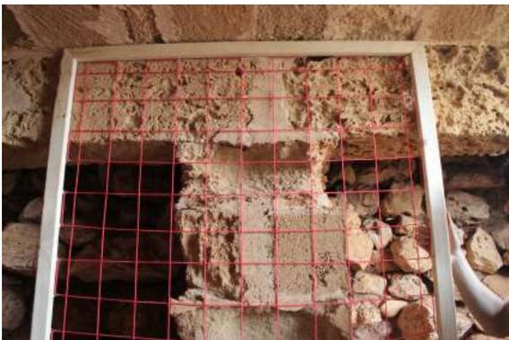
Fig. 130.70: Rilievo fotografico - quadrettatura di un campione di muratura dell'apertura a Sud-Ovest. In questo tratto è visibile il sacco calcareo delle murature.
