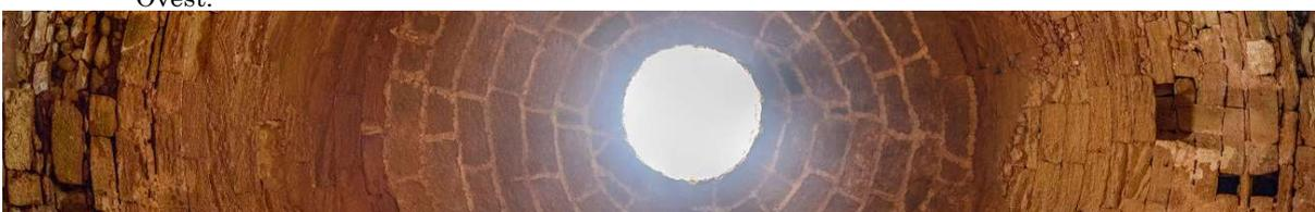
Fig. 115: Rilievo fotografico - dettaglio soffitto, dotato di lucernario per l'estinzione dei fumi delle armi.
