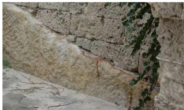
Fig. 110: Rilievo fotografico - dettagli. Antico piano di calpestio di accesso alla Torre, in cocciopesto, scavato per realizzare il posteggio automobilistico sotto l'arco.
