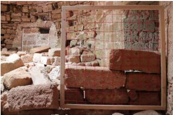
Fig. 130.68: Rilievo fotografico - quadrettatura di tracce murarie nell'ambiente interno.
