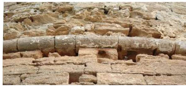
Fig. 108: Rilievo fotografico - dettagli. Cordolo calcareo di separazione tra basamento e coronamento.
