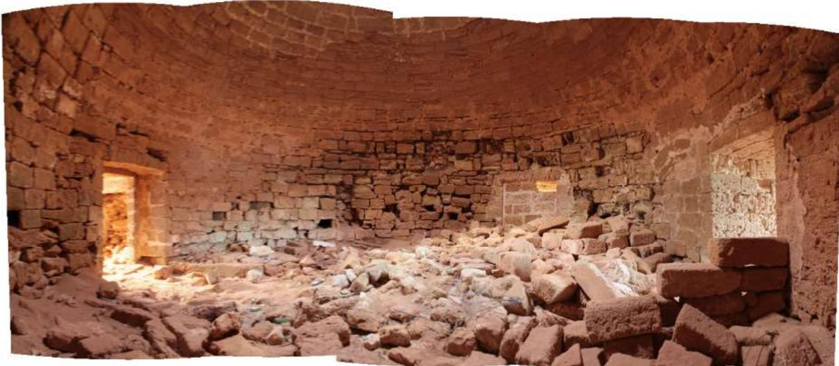
Fig. 116: Rilievo fotografico - composizione di fotografie dell'ambiente interno. Si confondono con i crolli alcune tracce di partizioni interne.
